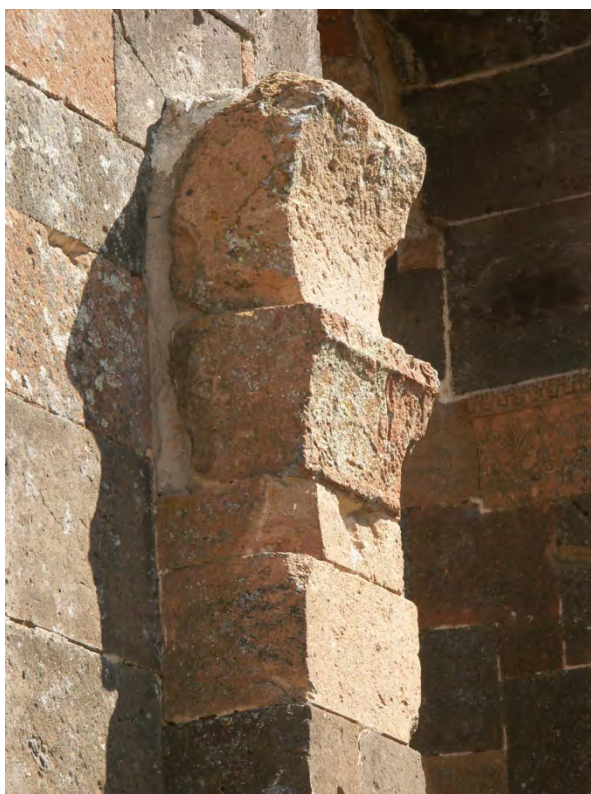
Fig. 133 : Voussoir sur pilastre nord, galerie nord. Cliché de P. Donabédian, LA3M, 2012.
