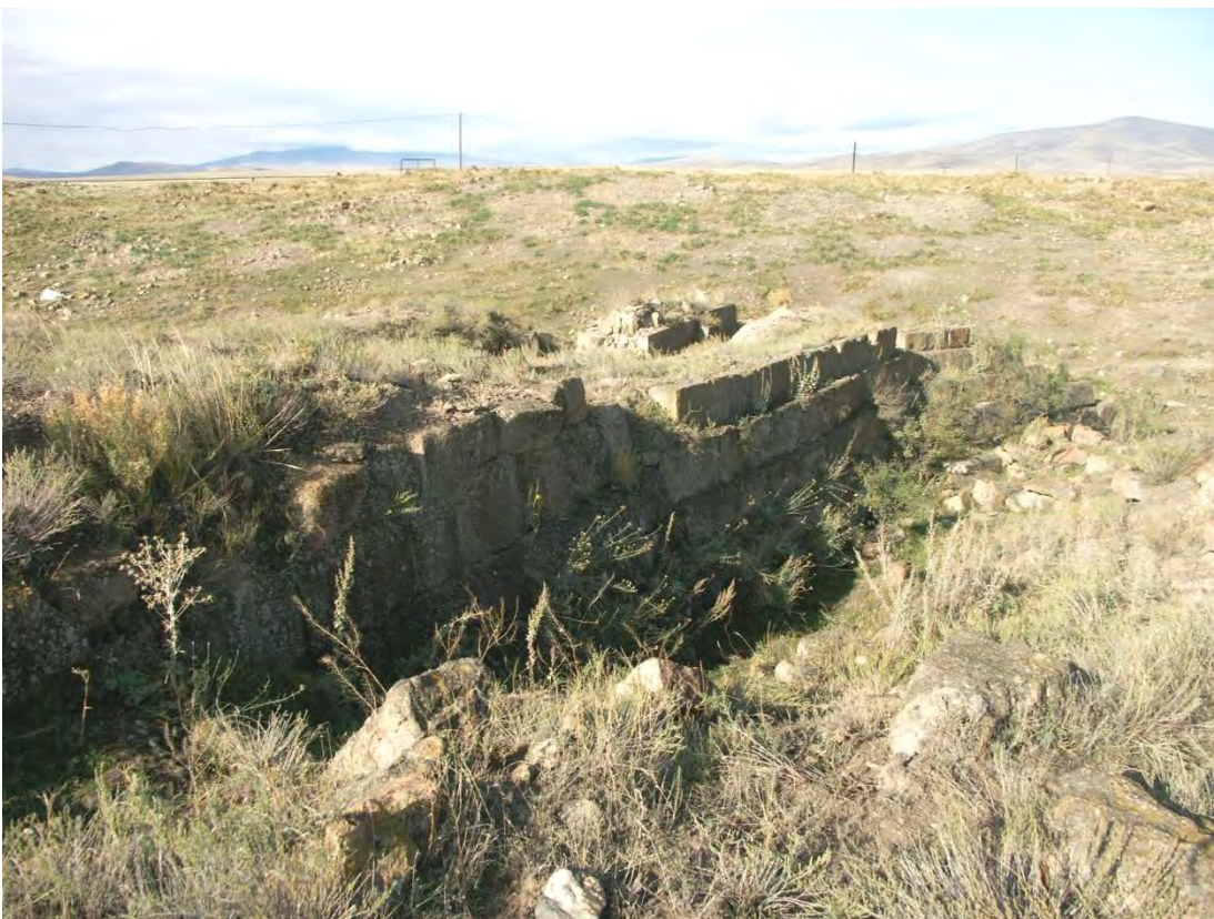
Fig. 19 : « Barrage ». Mur nord, face vers l'amont. Cliché de P. Donabédian, LA3M, 2010.
