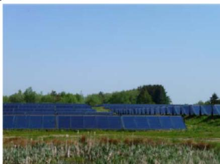
Photo 2. Centrale solaire thermique connectée au réseau de chaleur de Braedstrup (Danemark)
