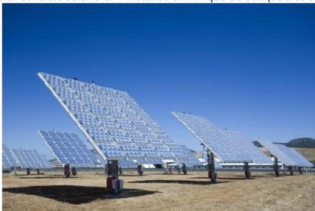
Cette centrale solaire de 500 kWc a été installée dans une région du globe avec un fort taux d’ensoleillement direct (DNI). En effet, le CPV nécessite un DNI supérieur à 1800 kWh/m<sup>2</sup>/an typiquement, dont ne bénéficient pas toutes les régions du globe : cf. Figure 3 ci-après.
