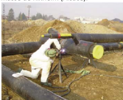
Photo 1. Préparation de canalisations pré-calorifugées pour le réseau de chaleur branché sur un doublet géothermique couplé à une chaufferie bois (Source Médiathèque RTE)
