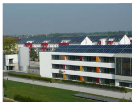
Photo 3 – Champ de capteurs solaires intégrés au bâti et connecté au réseau de chaleur de Crailsheim (Allemagne)
