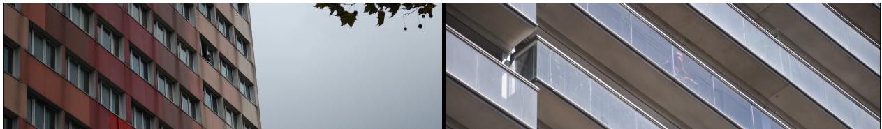
Détail de la façade avant et après travaux
