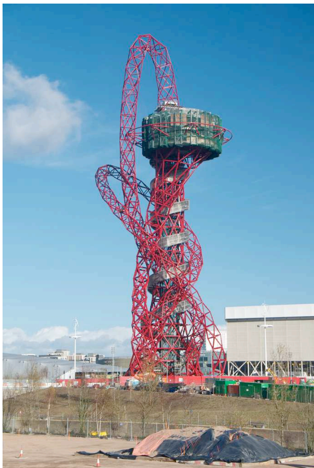
Photo 4 - La tour ArcelorMittal Orbit en novembre 2011. La double plate-forme d'observation est visible, enveloppée par des lacets d'acier et reliée au sol par un ascenseur.
