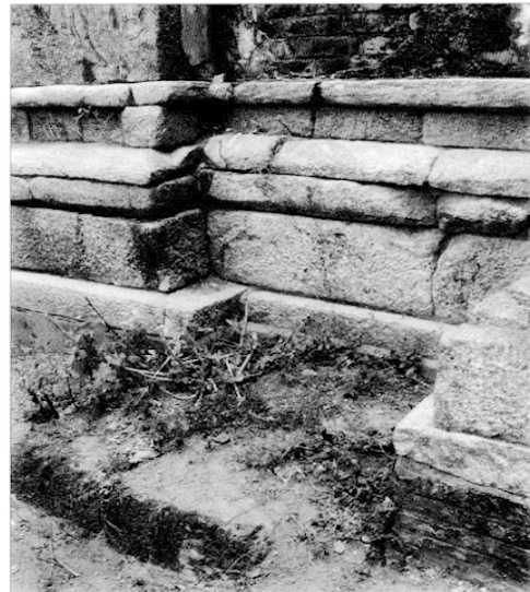
Fig. 10 Fondations en latérite du Vidyāvinītapallavaprameśvaragrha à Kūram. Cliché : Ch. Schmid.
