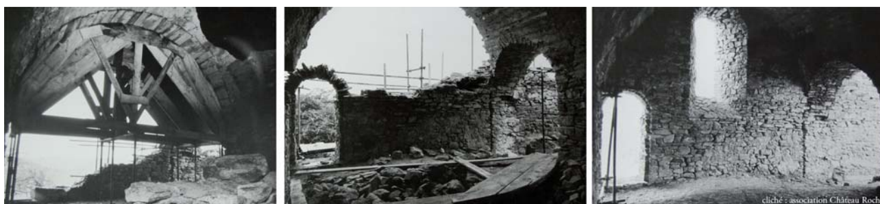
Fig. 7 : Vue de la pièce 14 en cours de restauration depuis le sud (association Château Roche).
