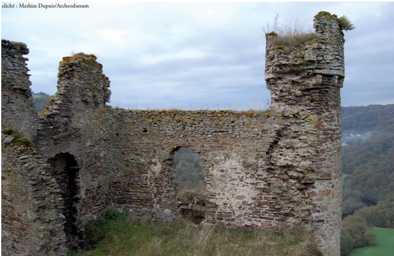
Fig. 11 : Vue de l'étage supérieur de la pièce 14 depuis le nord-est (Mathias Dupuis / Archeodunum).
