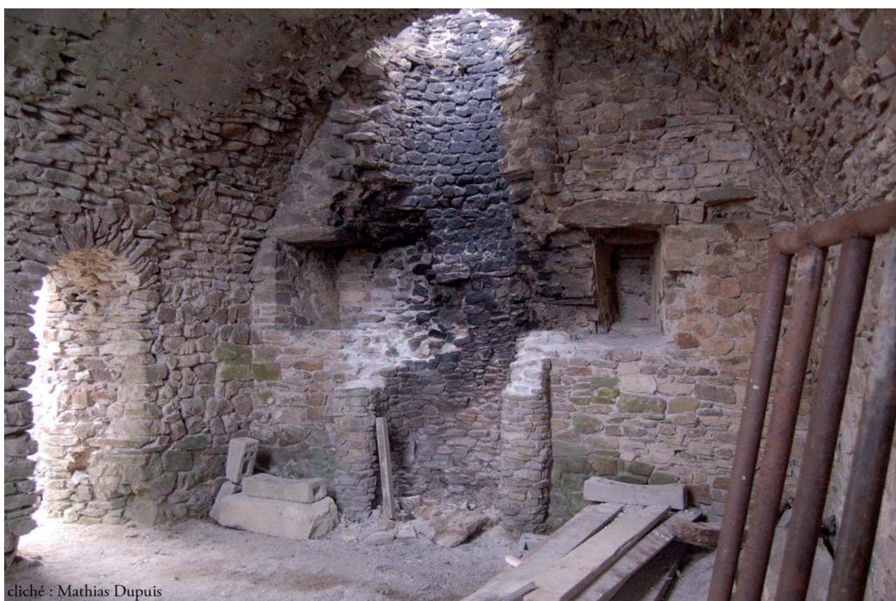
Fig. 8 : Vue de la pièce 14 depuis le nord, cheminée à foyer arrondie encadrée par les deux baies ébrasées (Mathias Dupuis).
