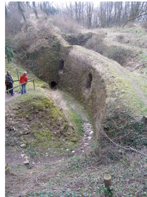
▼ Fig. 7 : vue extérieure d'un bastion casematé, après dégagement (cl. N.F.)
