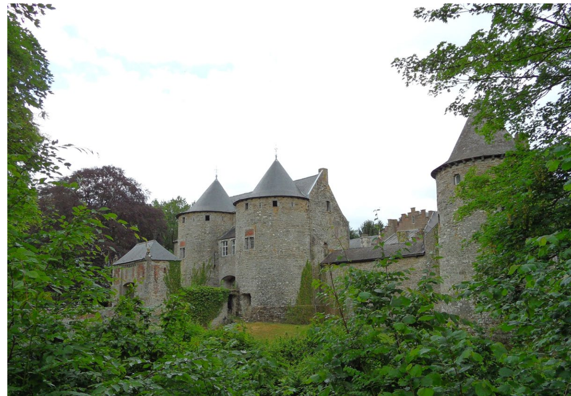
▲ Fig. 14 : château de Corroy-le-Château vu du sud-ouest.
