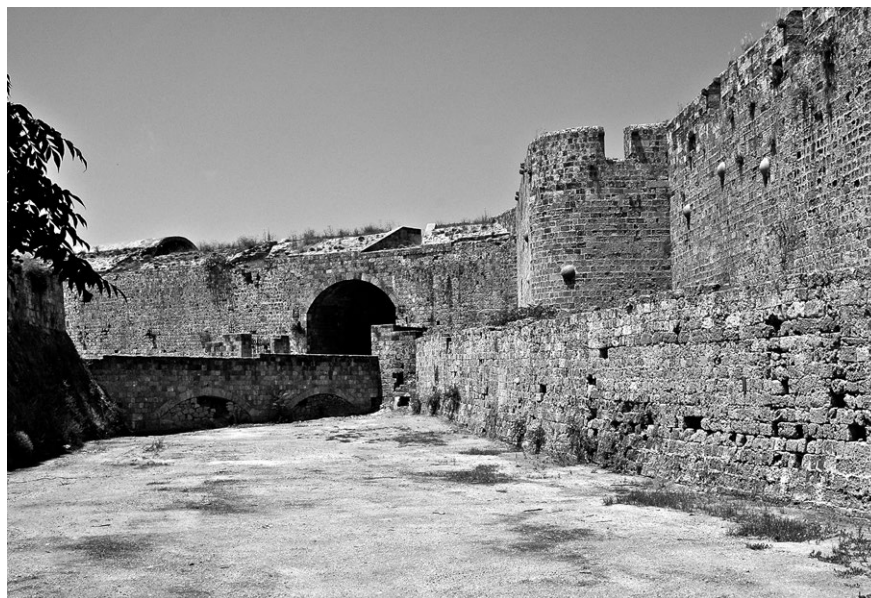
► Fig. 38 : le secteur méridional du poste d'Italie. C'est pour commémorer les attaques turques que l'on conserva et inséra, après le siège, des boulets lancés par les bombardes ennemies. Le tunnel que l'on voit au centre fut percé dans la tenaille par les autorités italiennes pour y faire passer une route d'accès à ce secteur du bourg. C'est derrière la partie droite de la courtine que furent édifiées, sur les instructions de Pierre d'Aubusson, les deux chapelles Notre-Dame de la Victoire et Saint-Pantaléon.
