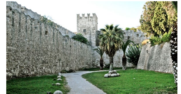
▲ Fig. 17 : la tour de Plaignes, vue des fossés.
