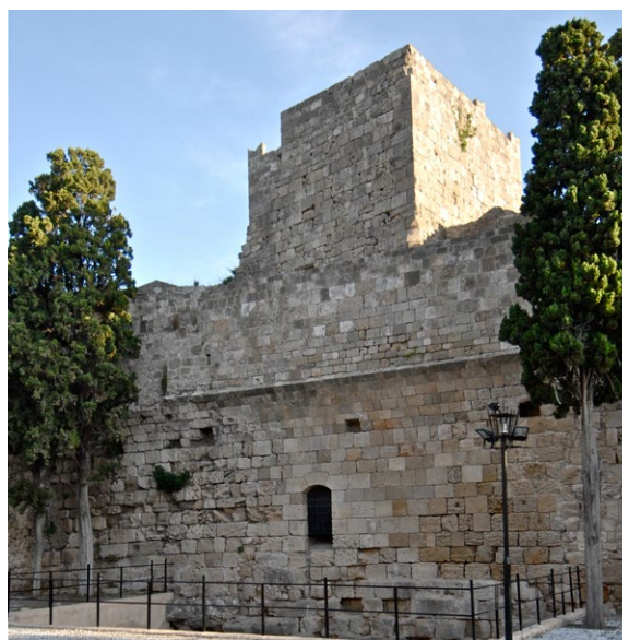
▼ Fig. 23 : la paroi interne de la courtine, derrière l'une des tours Heredia, vers l'arsenal.
