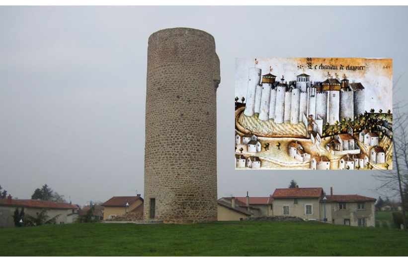
▲ Fig. 10 : la tour maîtresse de Cleppé : comparaison entre la vue de l'armorial et la tour actuellement visible (d'après BnF, fr. 22 297, p. 445 et LAFFONT, L'armorial... p. 147 et sq.)
