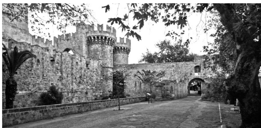
► Fig. 47 : de droite à gauche, la porte Saint-Antoine, les deux tours de la porte des canons et la courtine intérieure occidentale du palais.
