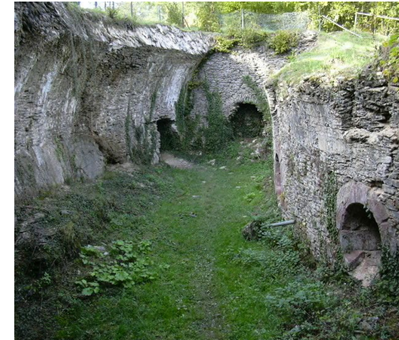
▼ Fig. 8 : vue intérieure d'un bastion casematé avec sa voûte crevée (cl. N.F.)
