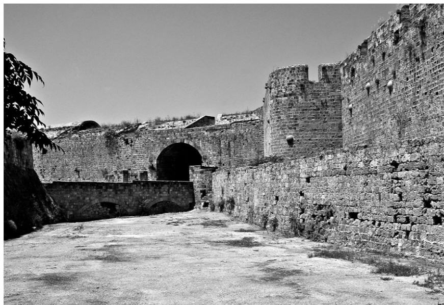
► Fig. 38 : le secteur méridional du poste d'Italie. C'est pour commémorer les attaques turques que l'on conserva et inséra, après le siège, des boulets lancés par les bombardes ennemies. Le tunnel que l'on voit au centre fut percé dans la tenaille par les autorités italiennes pour y faire passer une route d'accès à ce secteur du bourg. C'est derrière la partie droite de la courtine que furent édifiées, sur les instructions de Pierre d'Aubusson, les deux chapelles Notre-Dame de la Victoire et Saint-Pantaléon.
