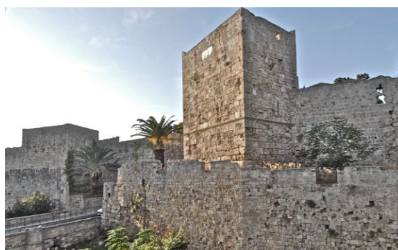
▲ Fig. 21 : les deux tours Heredia, sur la courtine septentrionale.
