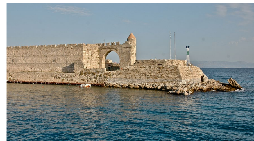
◀ Fig. 27 : base de la tour de Naillac, l'ancienne arche d'accès et l'amorce du « corridor ».
