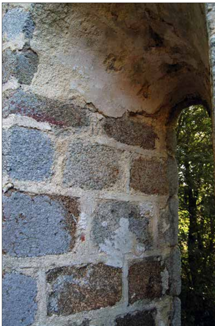
Fig. 4 - Saint-André-des-Eaux (Côtes-d'Armor), ancienne église Saint-André, chœur, détail de l'appareillage du piédroit nord de la baie axiale. Cl. Mathias Dupuis
