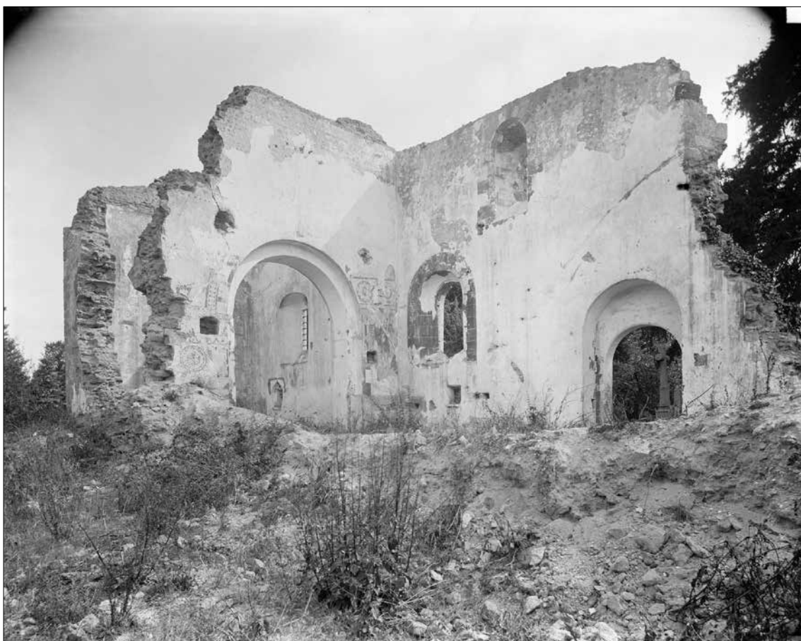
Fig. 2 - Saint-André-des-Eaux (Côtes-d’Armor), ancienne église Saint-André, vue de l’édifice depuis le nord-ouest en 1916. Cl. Ministère de la Culture, Médiathèque de l'architecture et du patrimoine
