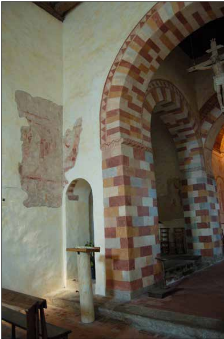
Fig. 16 - Saint-Cénéri-le-Gérei (Orne), église Saint-Cénéri, vue de la croisée du transept depuis le sud-ouest. Cl. Mathias Dupuis
