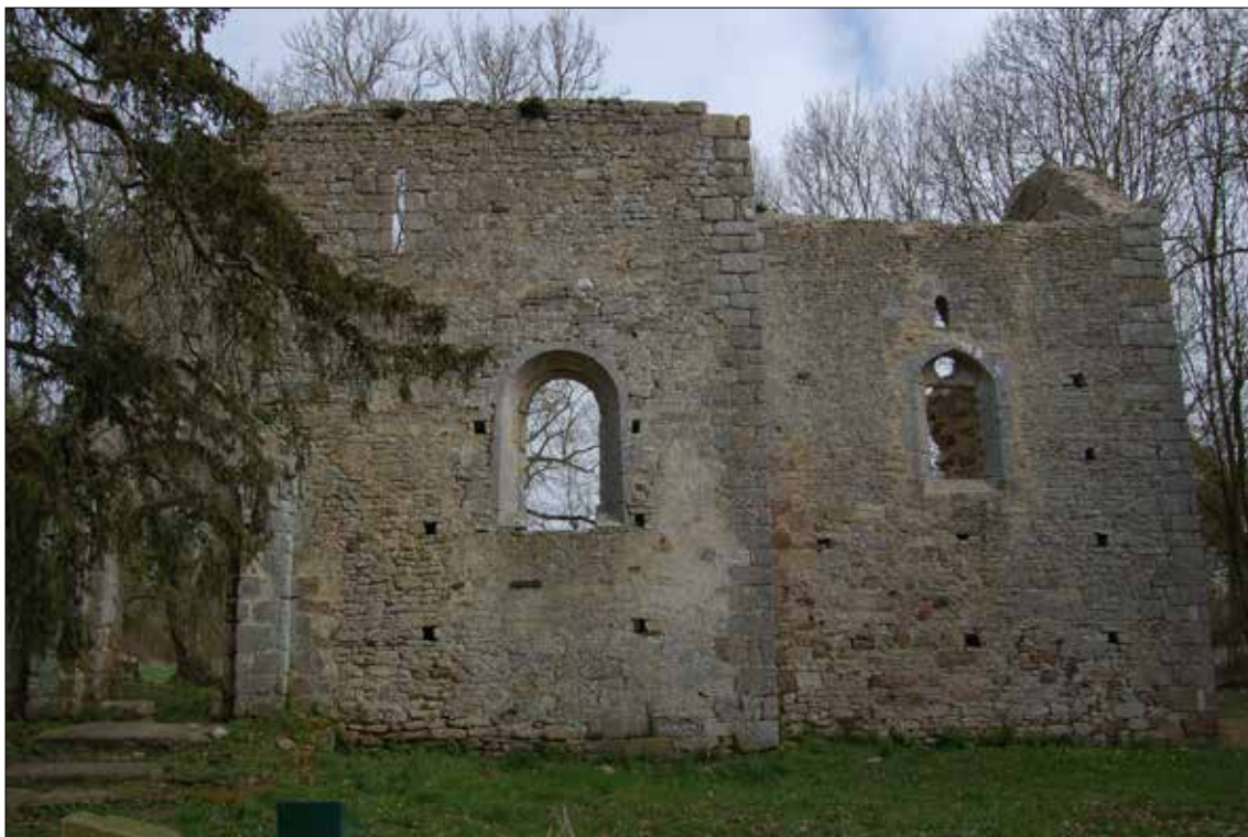
Fig. 1 – Saint-André-des-Eaux (Côtes-d’Armor), ancienne église Saint-André, vue de l’édifice depuis le sud. Cl. Mathias Dupuis
