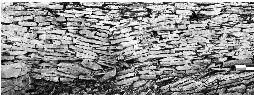
Fig. 16. Désordres de la maçonnerie sur le parement interne du mur gouttereau ouest de la grange de la ferme 2 (cliché P. Beck).
