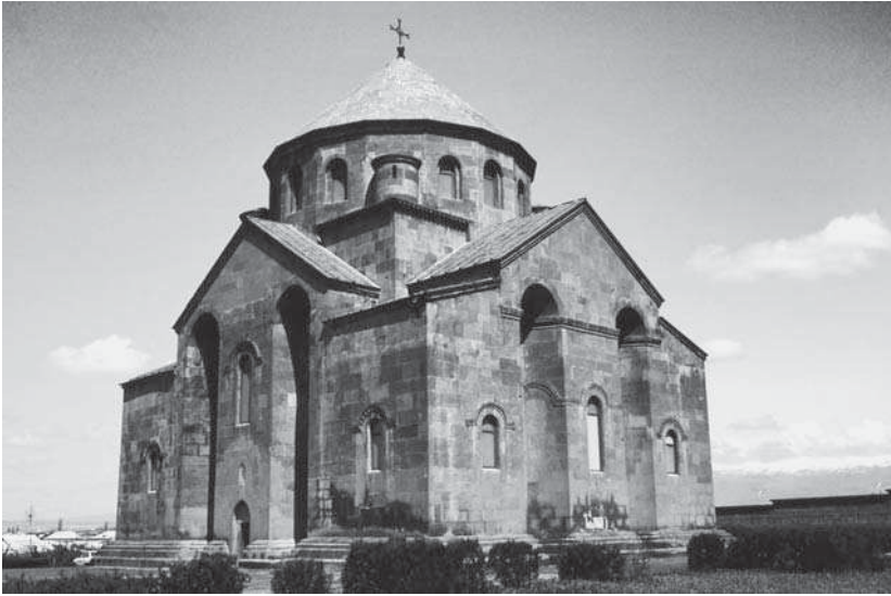
Fig. 17 Vaharšapat, Surb Hrip'simē. Vue générale sud-est.
