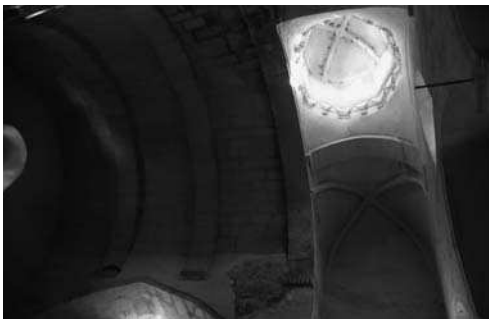
Fig. 12b. Intérieur, voûte longitudinale et coupole
