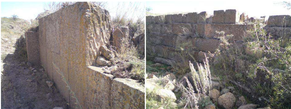
Fig. 13 – Ereruyk, 3 e et 4 e murs du « barrage ». Face nord (amont) (photo A. Hartmann-Virnich).
