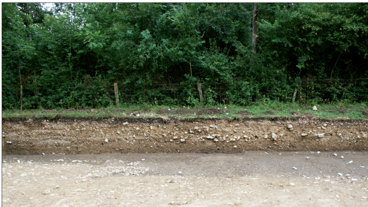
Fig. 8 - Vue des niveaux de colluvions (CO 7016) surplombant l'occupation du Cul de Breuil (Cliché : B. Bonaventure).
