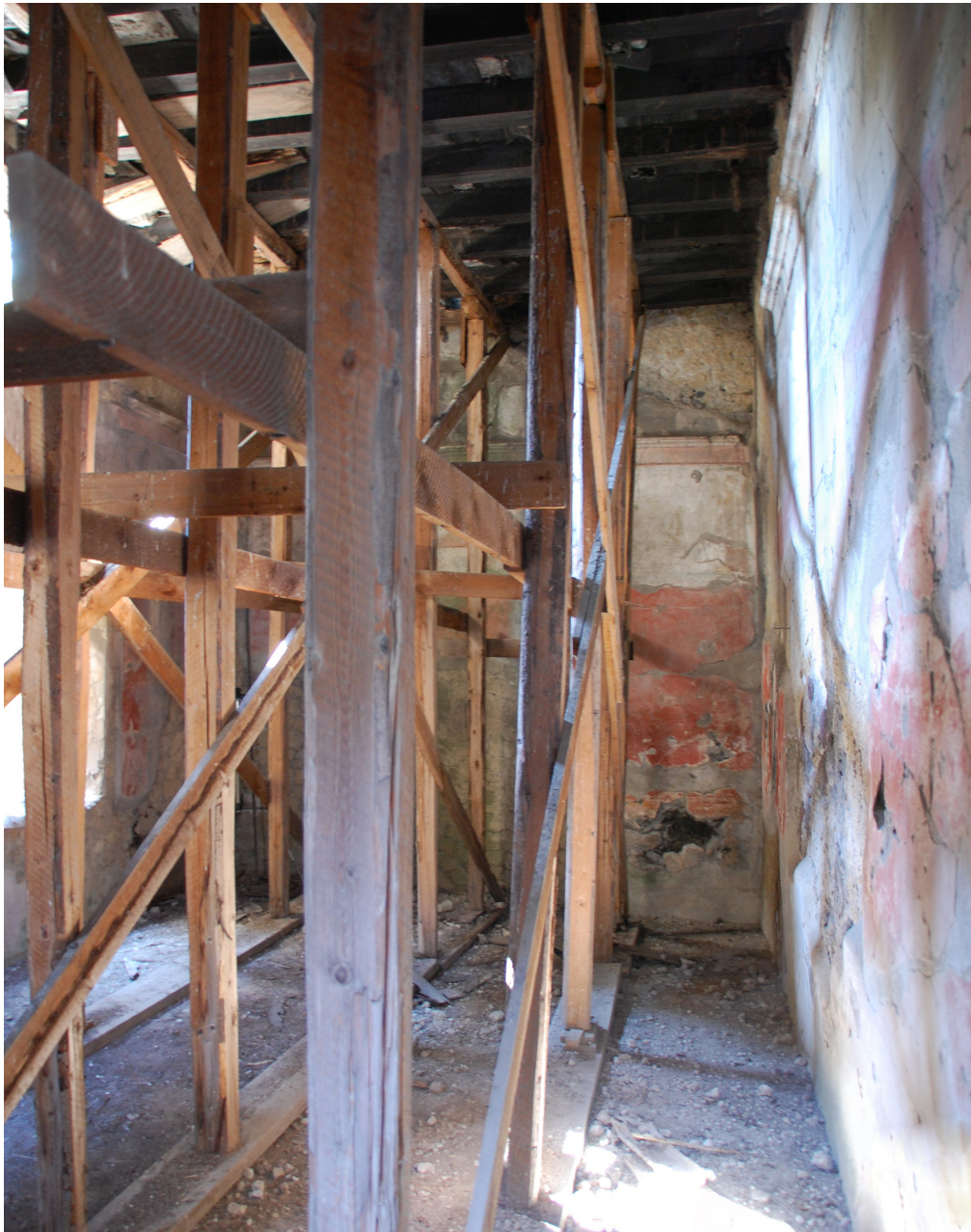
Fig. 9 - Herculanum V, 31 (Casa del Sacello di Legno), pièce 5.
