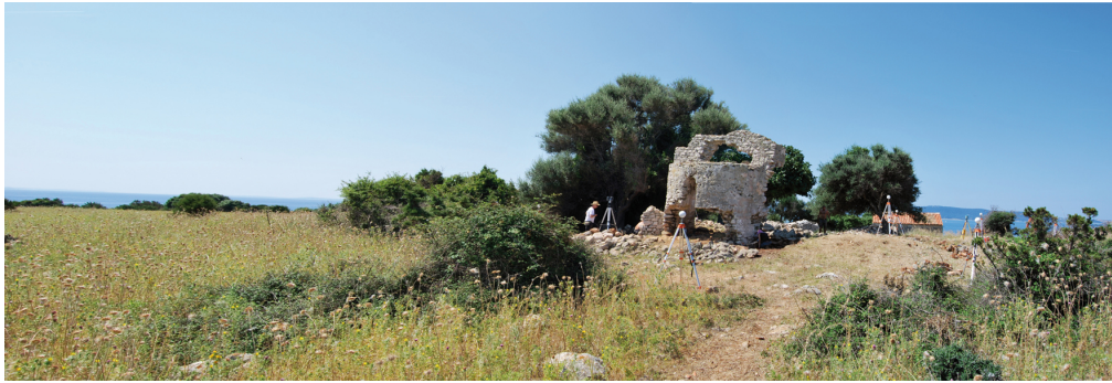
Fig. 9 - Oruda, vue générale des vestiges de l'église après débroussaillage.
