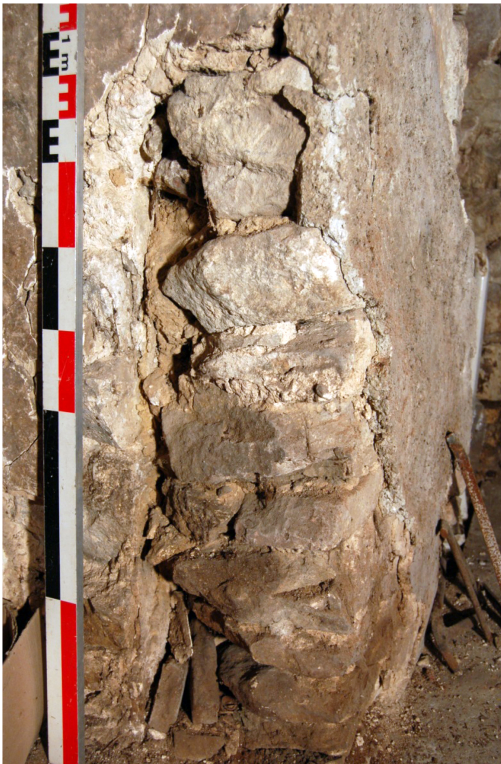
Fig. 9 - Baume-les-Messieurs, détail d'une niche (obturée) de l'hypothétique arcature aveugle du mur nord (cl. S. Bully).
