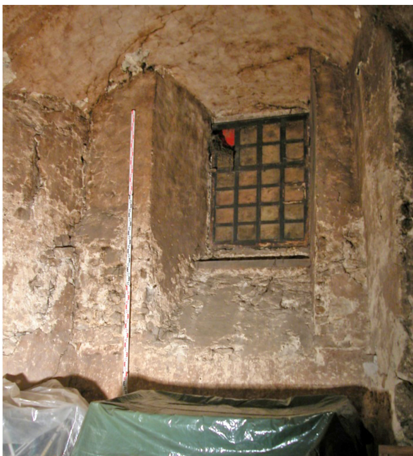
Fig. 10 - Baume-les-Messieurs, vue du mur ouest avec les traces d'arrachements de l'absidiole primitive (cl. S. Bully).
