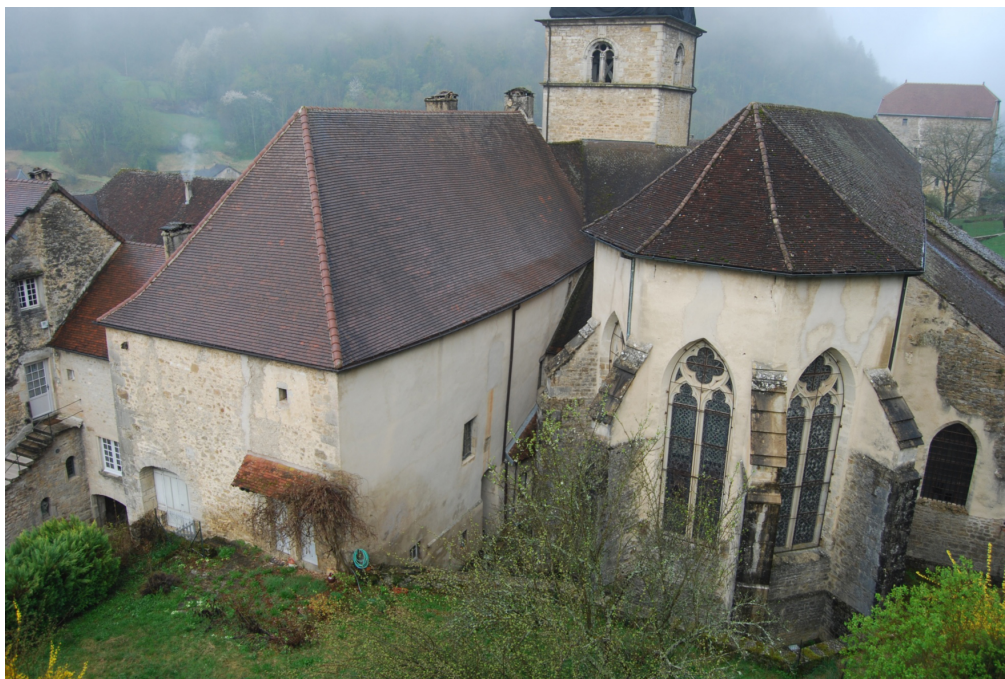
Fig. 2 - Baume-les-Messieurs, vue générale depuis le nord-est de l'ancienne chapelle de Salins transformée en maison (cl. S. Bully).
