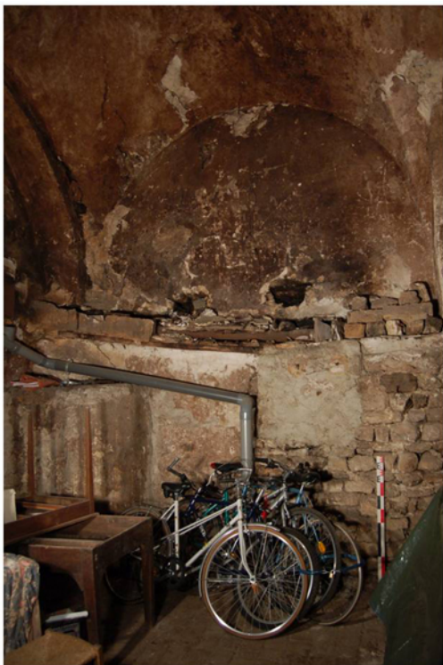
Fig. 4 - Baume-les-Messieurs, vue du mur sud de la « cave Domerc », première travée de la chapelle (cl. M.-L. Bassi).
