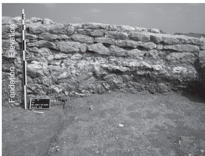
Fig. 32 – Parement ouest du mur MR6004 (cliché : P.-E. Beau, CERAGAS).
