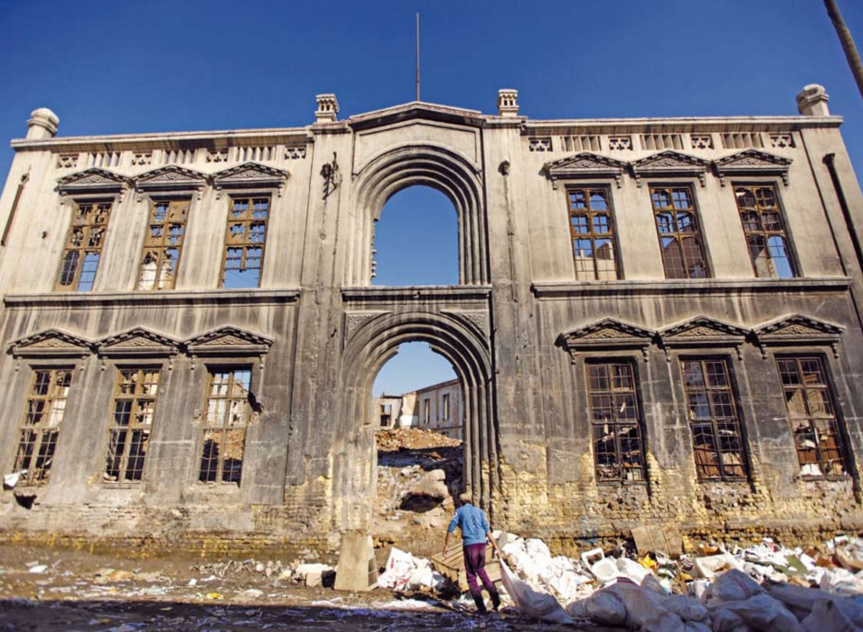
Déjà endommagé par les guerres successives, le patrimoine urbain moderne de Bagdad est sur le point de disparaître. Cette bibliothèque a été incendiée et pillée en 2003.
