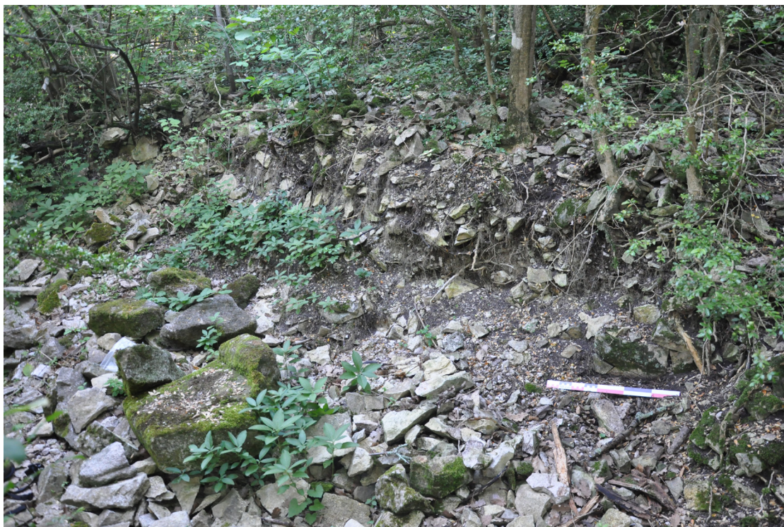
Fig. 13 : Zone du « Montpourchier », première enceinte : l'état actuel du sondage effectué par M. Marandet en 1966
