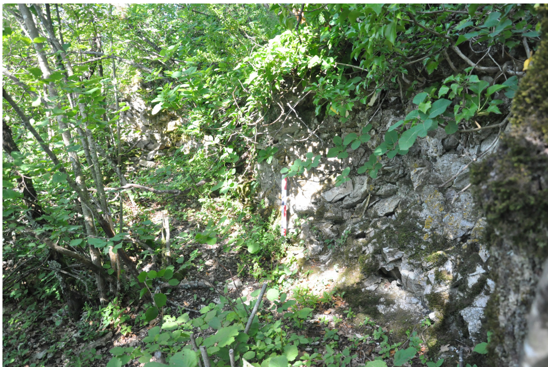
Fig. 15 : Zone du « Montpourchier », mur avec trou de « boulin » : vue vers l'ouest du mur maçonné. Certainement le mur «Chappe»
