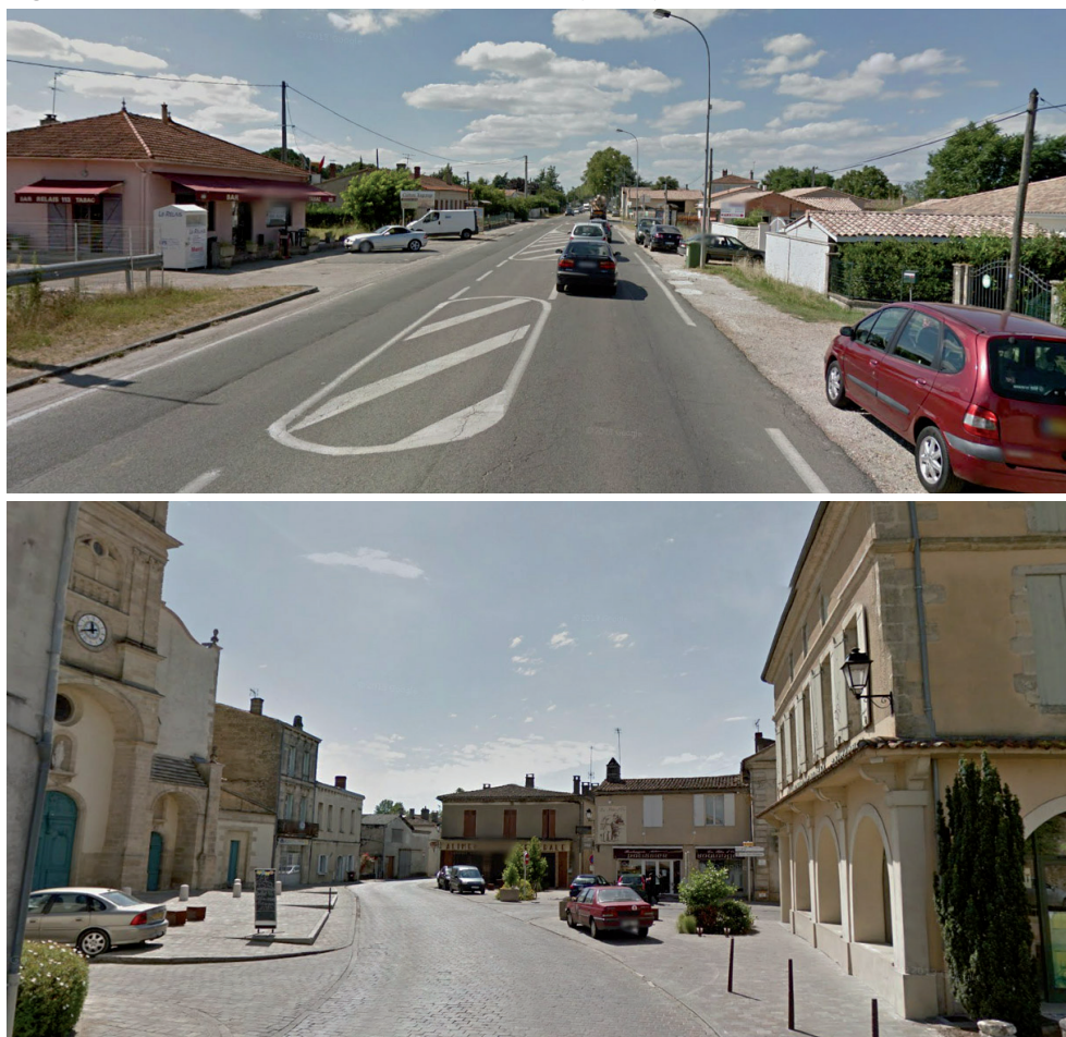
Figure 7 et 8 : Traversées d'Arbanats et de Barsac (D1113)
