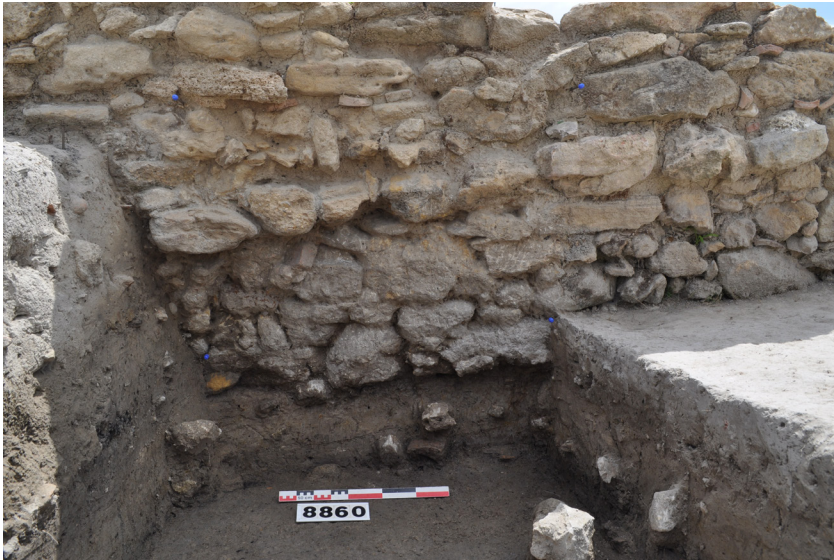
Fig. 9 : Le mur oriental de la cour montrant le remblai (55113) de destruction et nivellement sur lequel l'assise de base du mur a été construit; prise de l'Ouest.
