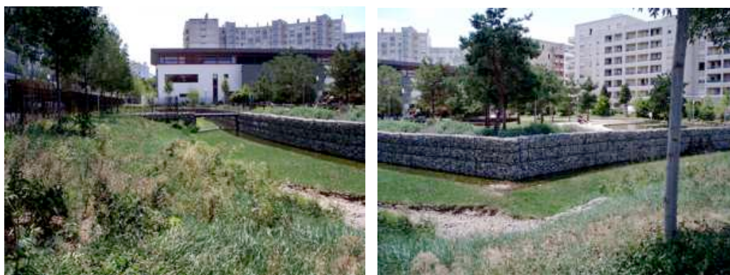
figure 3 : photographies du parc Jacob Kaplan : au premier plan, le bassin de rétention (2011)
