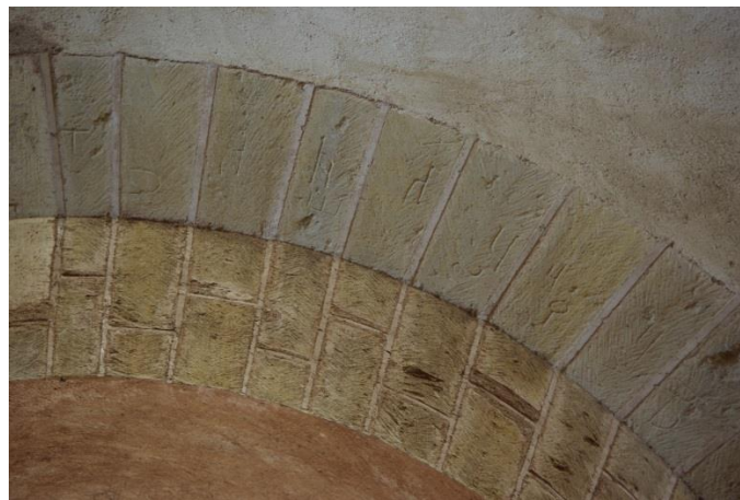
Fig. 10 – Sainte-Foy de Conques, exemple d'une composition variée des marques doubles, face est du doubleau séparant le massif occidental du collatéral sud de la nef.
