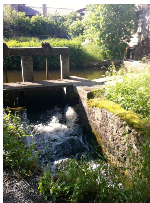
Etablissement Laurent : bief du moulin (Cliché : L. Rieutort)
