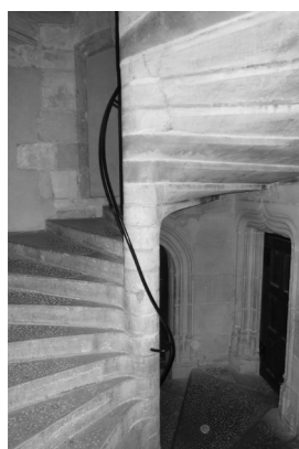
▲ Fig. 144 : sur le mur est de la cage d'escalier de la vis, on voit en haut la fenêtre de second jour qui éclaire le couloir desservi par la porte du 1 er étage, cachée par le noyau de la vis.
