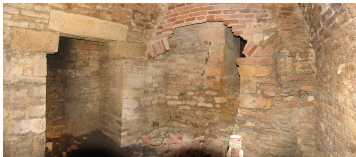
▼ Fig. 104 : vue panoramique de la moitié orientale de la fosse de latrines. À gauche, le renforcement des latrines nord ; au fond, l'arc de brique et le couloir de vidange.
