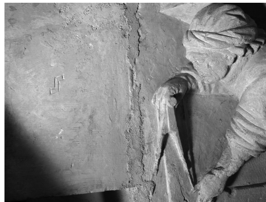
◀ Fig. 183 : marque de tâcheron à proximité du culot de l'architecte.
