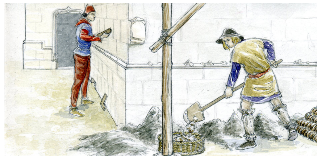
◀▲ Fig. 57 : le tamisage du bon repoux. Le 1 er mai 1452 (qui n'était pas férié), les ouvriers de bras Jean Dorizis et Pierre le Potier sont employés à ramasser le « bon repoux et sablon qui estoit cheuz en maçonant » le mur du pignon oriental. On remarque la pelle en bois renforcée d'un tranchant de fer. Le mortier ramassé est transporté « à la benaste » jusqu'à l'aire où il sera passé « à la cloye ». On aperçoit, derrière les échafaudages, les arcades dont les marques sont encore visibles au musée, devant le mur de l'accueil. À gauche, un maçon étalonne sa mesure. Dessin Lionel Duigou, 2014.
