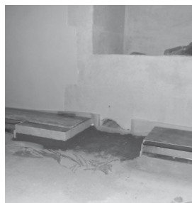
▲ Fig. 121 : pertuis d'évacuation sous l'évier, pendant travaux (8 février 2013). Le rehaussement du sol de l'échansonnerie n'a pas permis de mettre en valeur cet élément.
