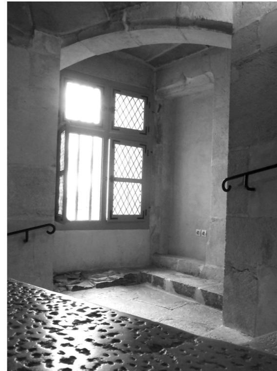
▲ Fig. 156 : grande vis, palier vers le passage sur le mur du castrum (au fond) et vers les retraits du 2 e étage (au fond à droite).
