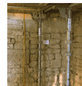
▲ Fig. 151 : empochement ouest dans le mur sud (décembre 2011).
