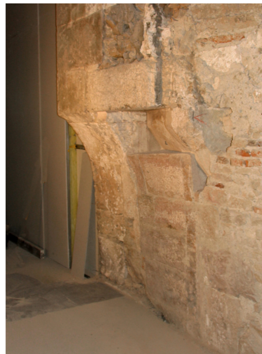
▼ Fig. 80 : embrasure externe du jour sud de l'escalier, 3 e étage. (L'angle sud-est de la tour a été délardé pour élargir le passage.)
