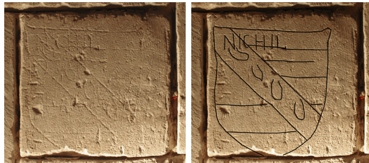
▲ Fig. 123 : graffiti héraldique sur le tableau interne d'une baie de l'échansonnerie.
