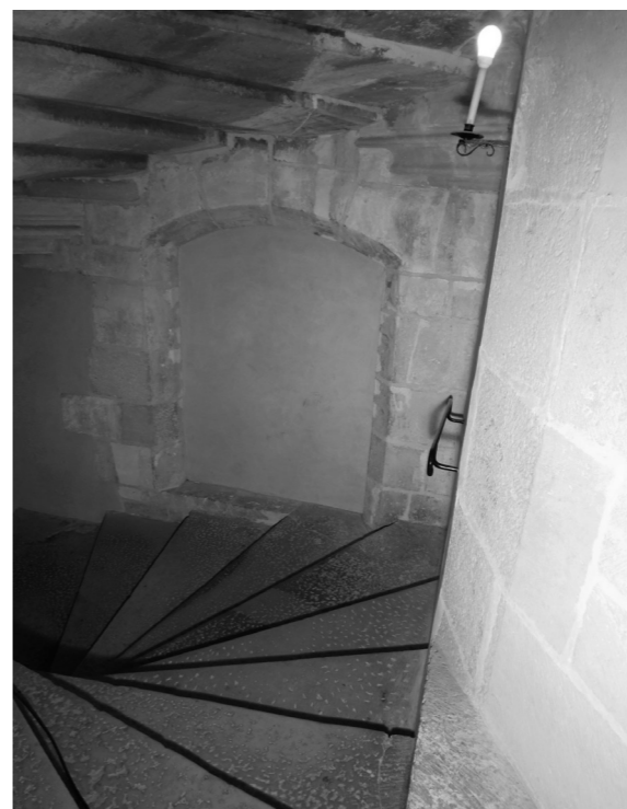
▲ Fig. 145 : fenêtre de second jour ; délardement de l'embrasure du jour d'escalier au premier plan.
