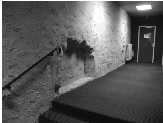
▲ Fig. 155 : partie supérieure de l'embrasure de second jour donnant dans la grande salle.
