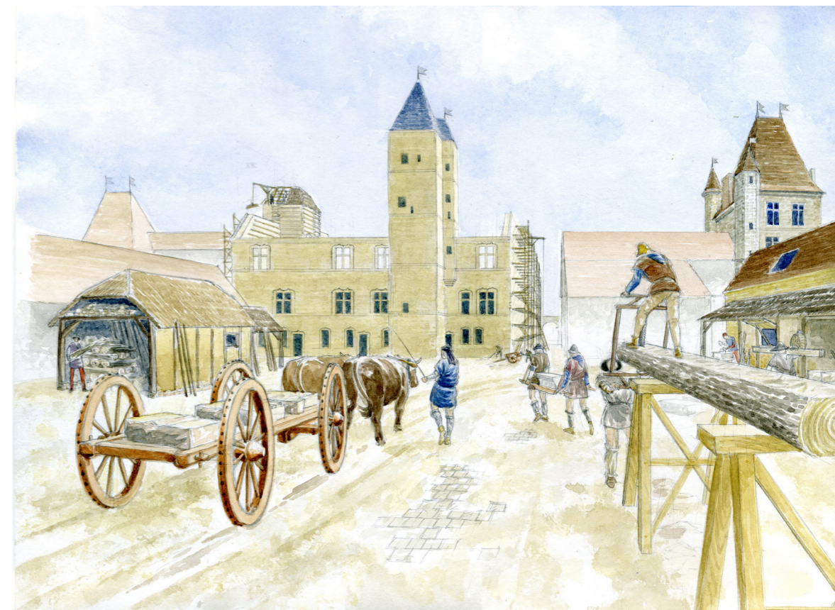
▲ Fig. 51 : évocation du chantier, le 13 mars 1452.
