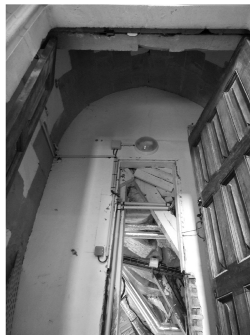
▲ Fig. 173 : 2 e étage de comble, vestibule vu depuis l'escalier. Le haut de la porte percée dans la cloison du fond est la fenêtre qu'on voit sur la fig. 174.
