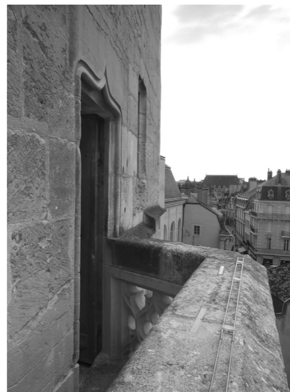
▲ Fig. 167 : porte entre les retraits du 1 er galetas et la coursière nord.
