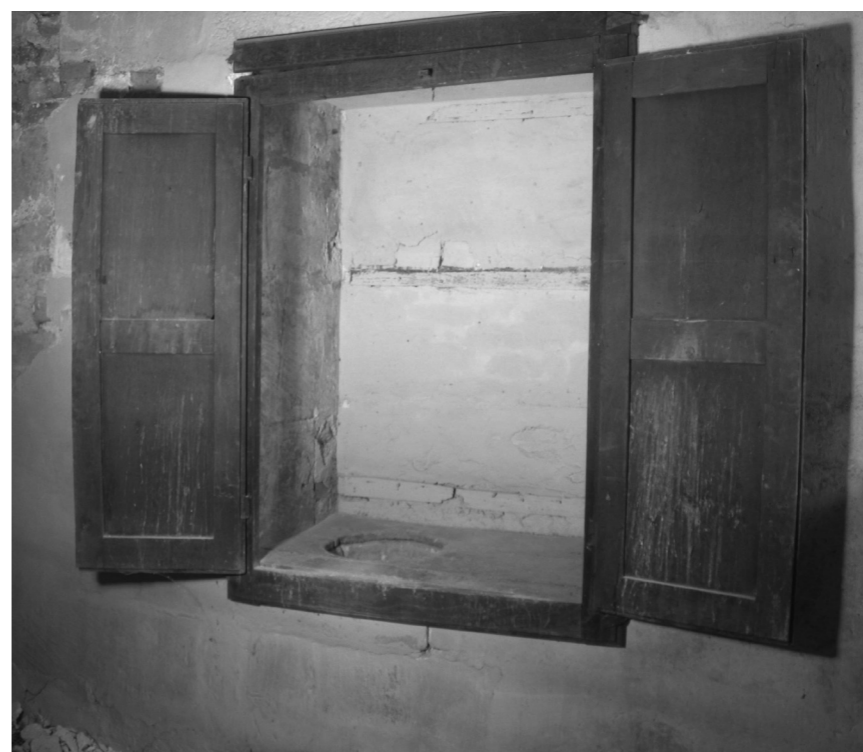
◀ Fig. 100 : 4 e étage de la tour de la Terrasse. Latrines en niche réutilisées en placard. L'orifice est décalé sur la gauche de façon à ce que la niche et le conduit viennent se plaquer contre le conduit qui descend du 5 e étage. Dans le fond de la niche, on voit les tasseaux de lambris. Sur les tableaux latéraux, les lambris étaient fixés par des crampons scellés au plomb, tout comme le siège.
