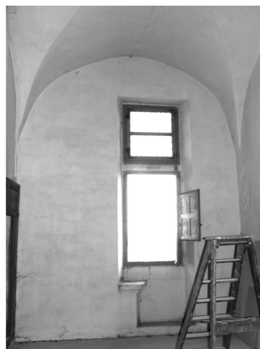
▲ Fig. 175 : 2 e étage de comble, garde-robe dans la tour, mur nord.
