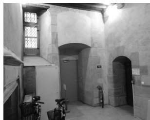
▲ Fig. 131 : garde-robe de la chambre basse devers Notre-Dame. À gauche, la cheminée, au centre la demi-croisée transformée en porte, à droite la porte vers la chambre.
