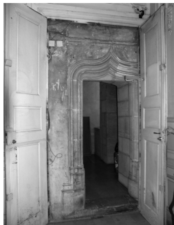
▲ Fig. 146 : porte entre la chambre et la garde-robe. Moulure périphérique de contact avec les lambris
