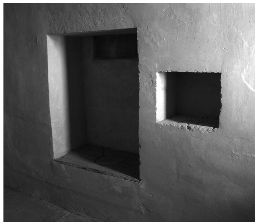
◀ Fig. 99 : 5 e étage de la tour de la Terrasse. Latrines en niche. Le siège, en bois, est vraisemblablement contemporain de la construction. Sur le parement, sous le siège, la lumière rasante fait apparaître un tasseau de lambris. L'orifice des latrines a été comblé.
