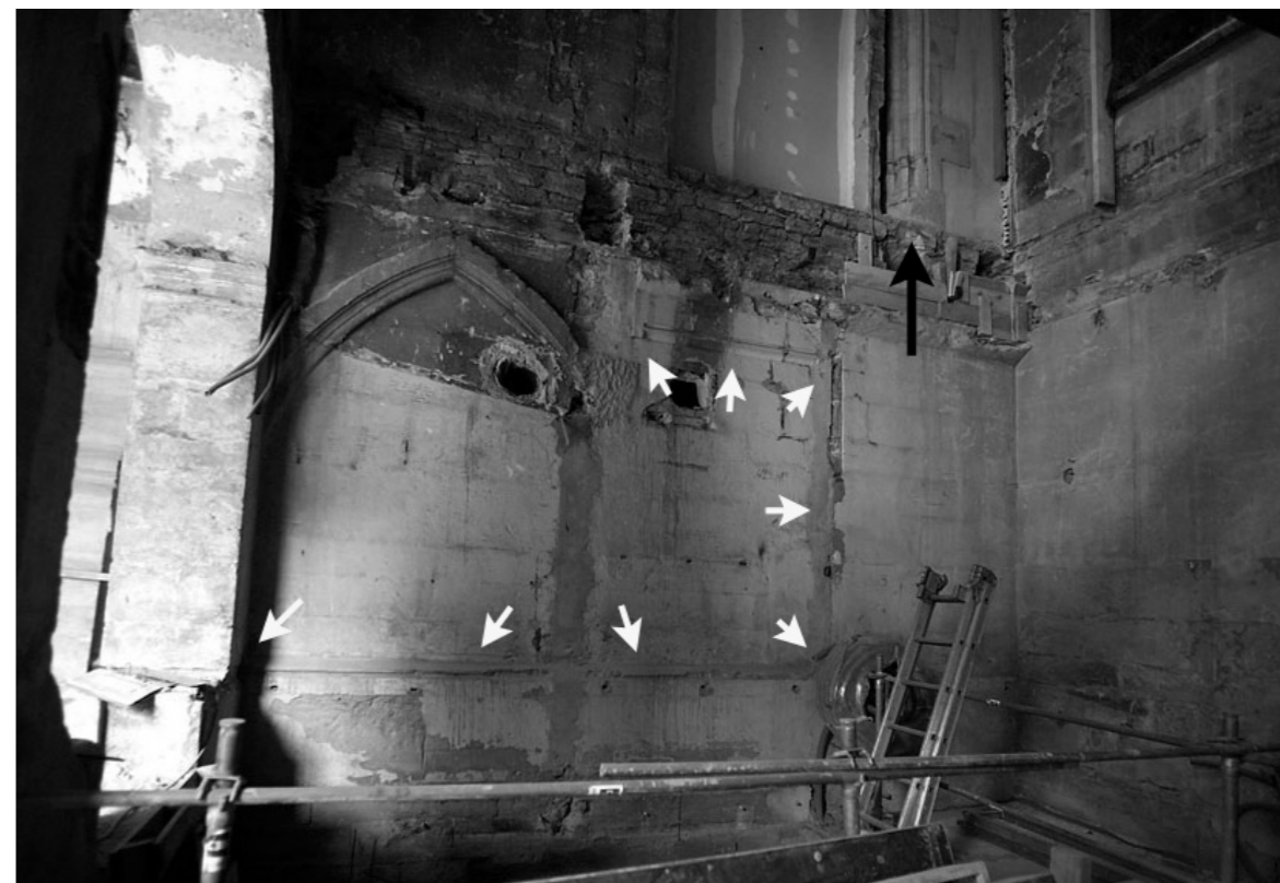
▲ Fig. 88 : façade est, rez-de-chaussée, travée nord, retournement de la plinthe sous le palier du 1 er étage et arc formeret, juin 2011 (cl. Sophie Jugie). Flèches blanches : moulures de la plinthe. Flèche noire : montant droit de la porte droite de la grande salle.
