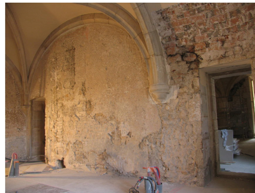
▲ Fig. 108 : relevé du parement oriental de la chambre de la vaisselle. On remarque les traces d'arrachement du parement de parpaing qui fermait les conduits du côté de la salle. En bas : plan des portes et des conduits de latrines. À droite de la porte droite, qui est moderne, on remarque une feuillure de la porte donnant dans la vis sud. Les rectangles de couleur indiquent les superpositions des revêtements peints. (Avril 2012.)
