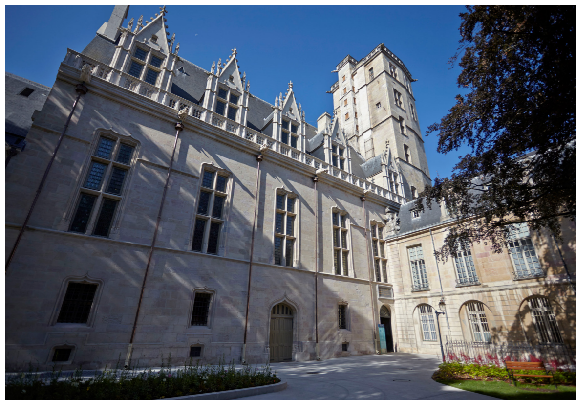
▼ Fig. 70 : la façade nord du palais en 2013. (Cl. Fr. Jay, musée des beaux-arts de Dijon).
