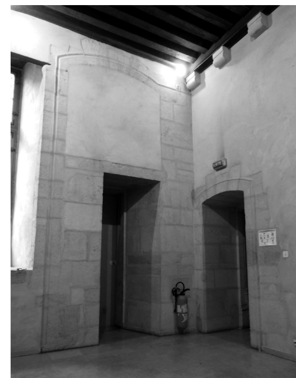
▲ Fig. 147 : garde-robe, porte moderne aménagée dans l'embrasure de la demi-croisée ; à droite, porte vers la chambre.
