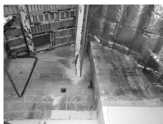
▲ Fig. 170 : pignon ouest, 1 er et 2 e étage de comble du musée (cl. S. Jugie, février 2012).
