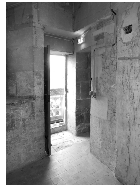
▲ Fig. 168 : embrasures des portes des retraits vers la coursière et vers la chambre ; réserve du tambour de porte.
