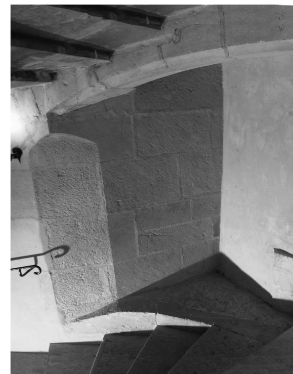
▲ Fig. 145 bis : embrasure du jour d'escalier avec délardement de l'embrasure.
