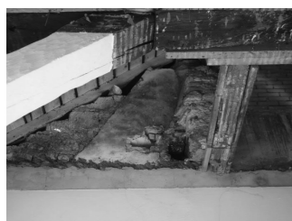
▲ Fig. 171 : trace de la toiture de 1503 conservée dans le mortier.
