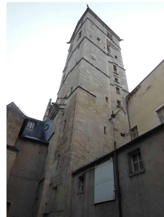
▼ Fig. 81 : tour de la Terrasse, vue du nord-ouest.
