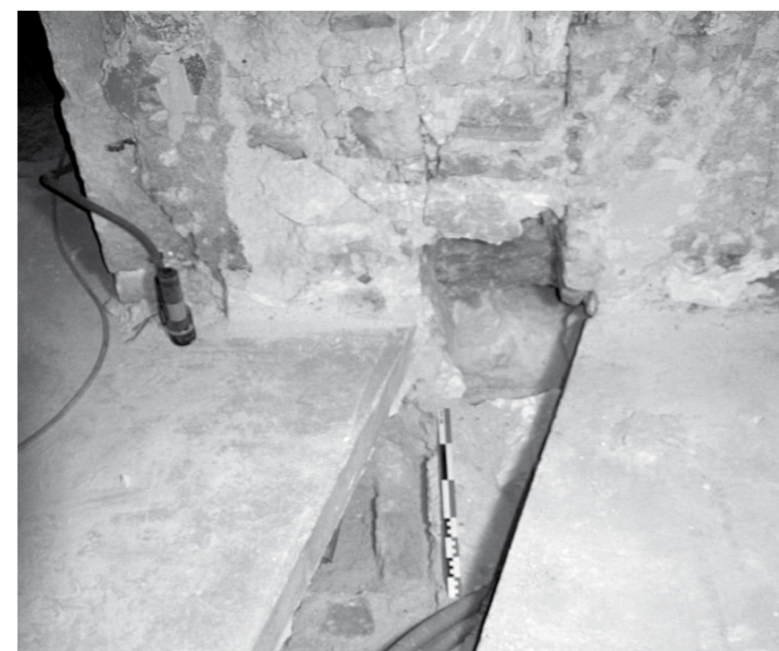
◀ Fig. 105 : latrines du rez-de-chaussée. L'orifice rectangulaire du conduit de latrines apparaît au fond du regard, à gauche de la mire. Le mur parpaing du cabinet était lié au montant de porte, visible à gauche. Sur le mur de maçonnerie, au centre, on voit un second conduit de latrines intramural (17 mars 2012).
