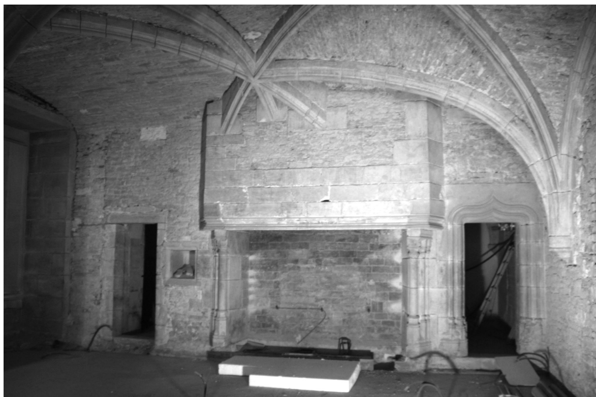
▲ Fig. 119 : mur ouest de la chambre de l'échansonnerie et cheminée. La porte de gauche est moderne, celle de droite conduit aux retraits et à la chambre de la vaisselle (cl. février 2012).
