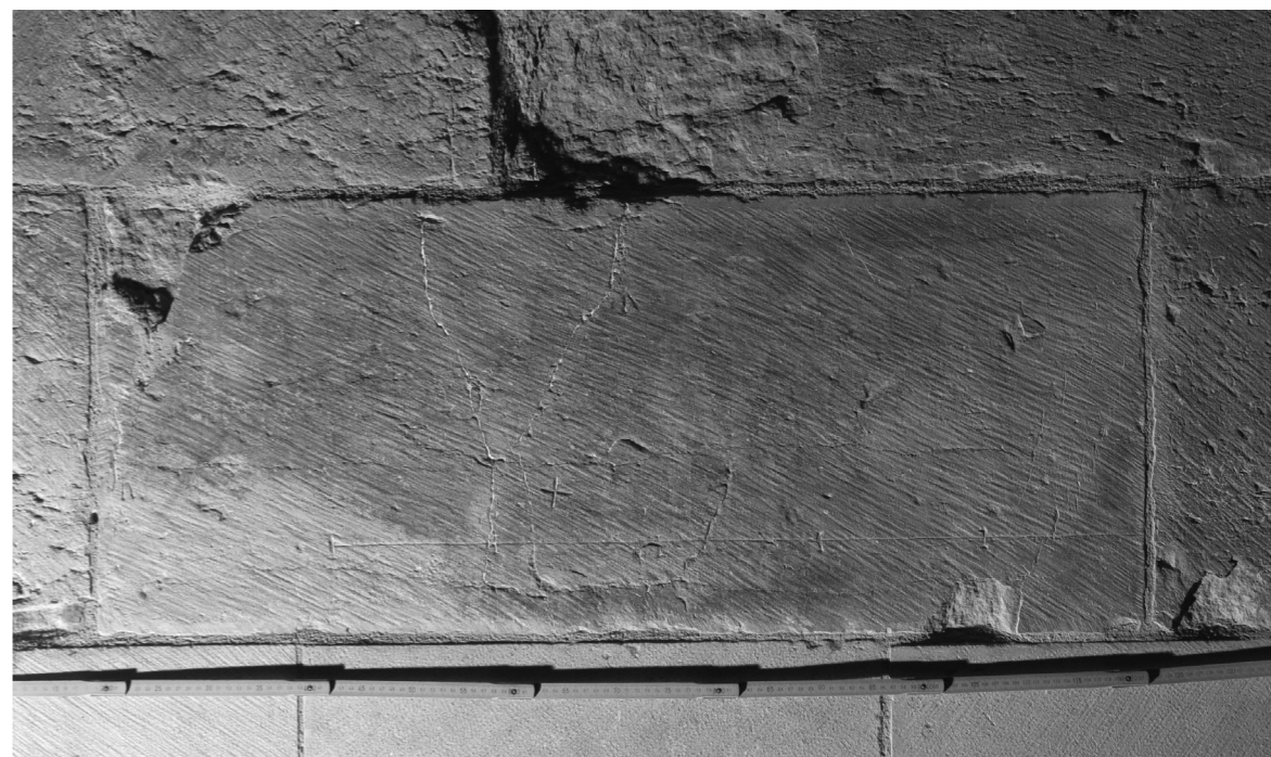
▲ Fig. 66 : à la base du mur sud (aujourd'hui devant l'escalier Robert de Cotte), un pied étalon de 5 demi-pieds de 16 cm chacun.
