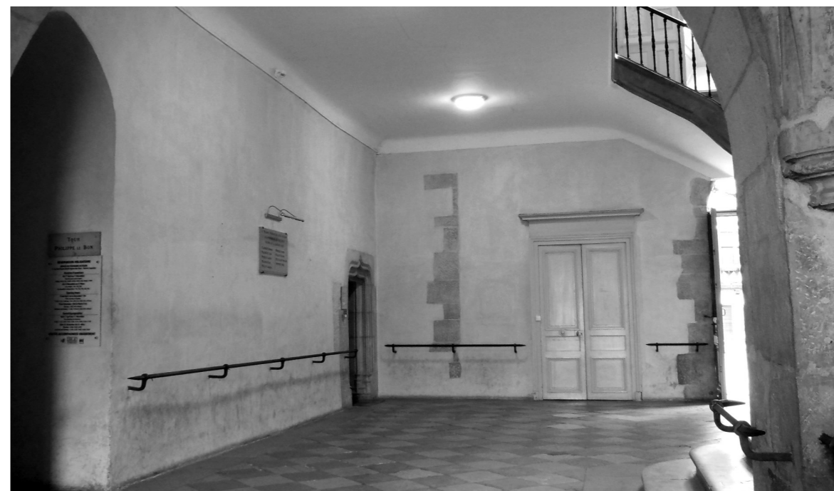
▲ Fig. 132 : la chambre devers Notre-Dame, aujourd'hui passage du roi. Au premier plan, le mur et le couloir nord-sud qui fermait la chambre au sud ont été démontés. Au fond, de gauche à droite : le montant gauche de la cheminée (confondu avec la porte), la porte vers la garde-robe, la chaîne d'angle gauche de la croisée et la porte vers la cour devers Notre-Dame, dont il reste une embase.
