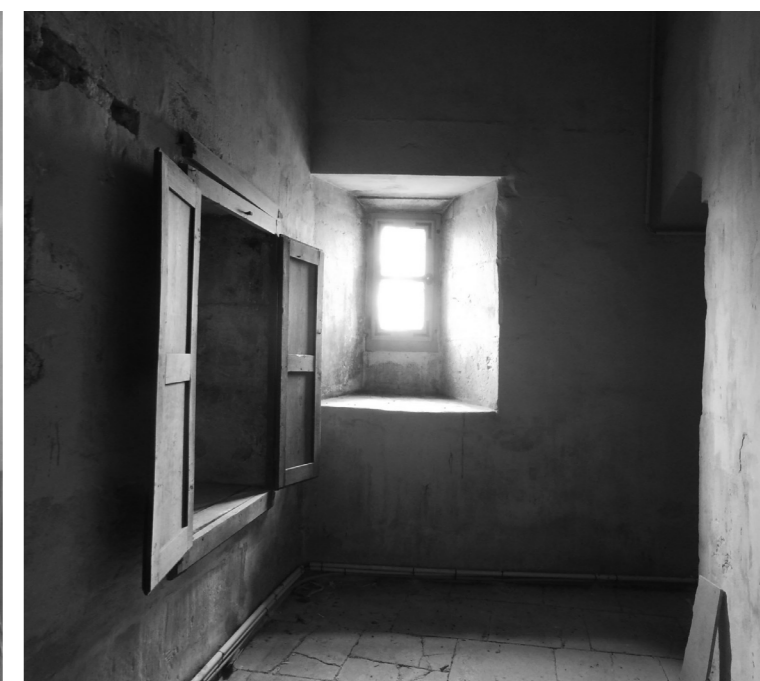
▲ Fig. 176 : 2 e étage de comble, retraits dans la tour. À gauche, latrines en niche transformée en placard.
