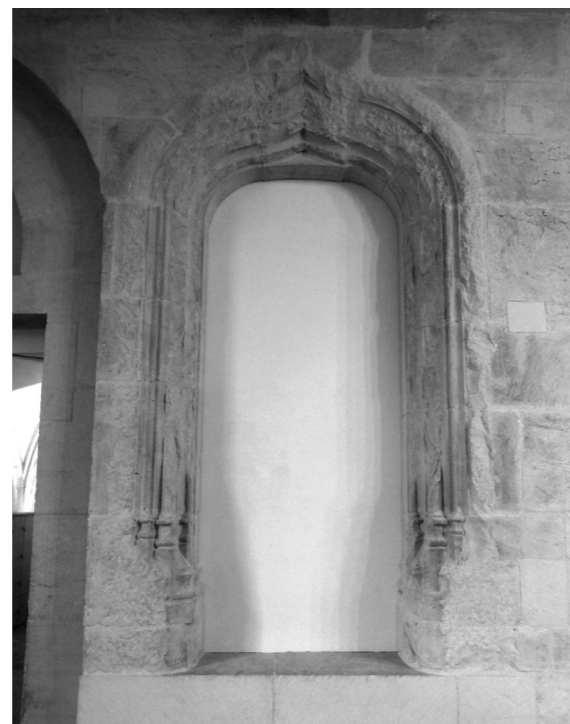
▲ Fig. 83 : baie de la chambre de l'échançonnerie (rez-de-chaussée).
