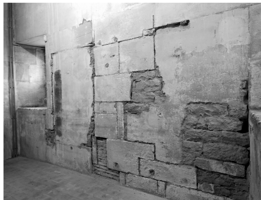
◀ Fig. 101 : 3 e étage de la tour de la Terrasse. Au centre de la photo, on voit les parpaings qui constituent la cloison côté salle des conduits des latrines du 4 e étage (à droite) et du 5 e (à gauche). De part et d'autre, on devine les ouvertures murées de deux latrines en niche.
