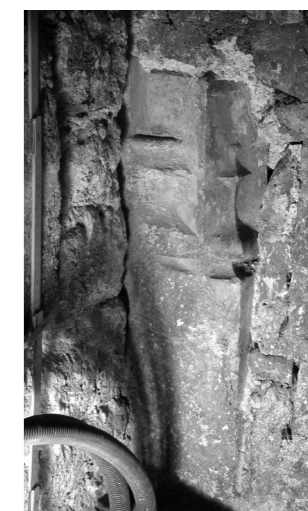
▲ Fig. 141 : piédroit de la porte de la chambre du duc, dans l'angle sud-ouest de la garde-robe.
