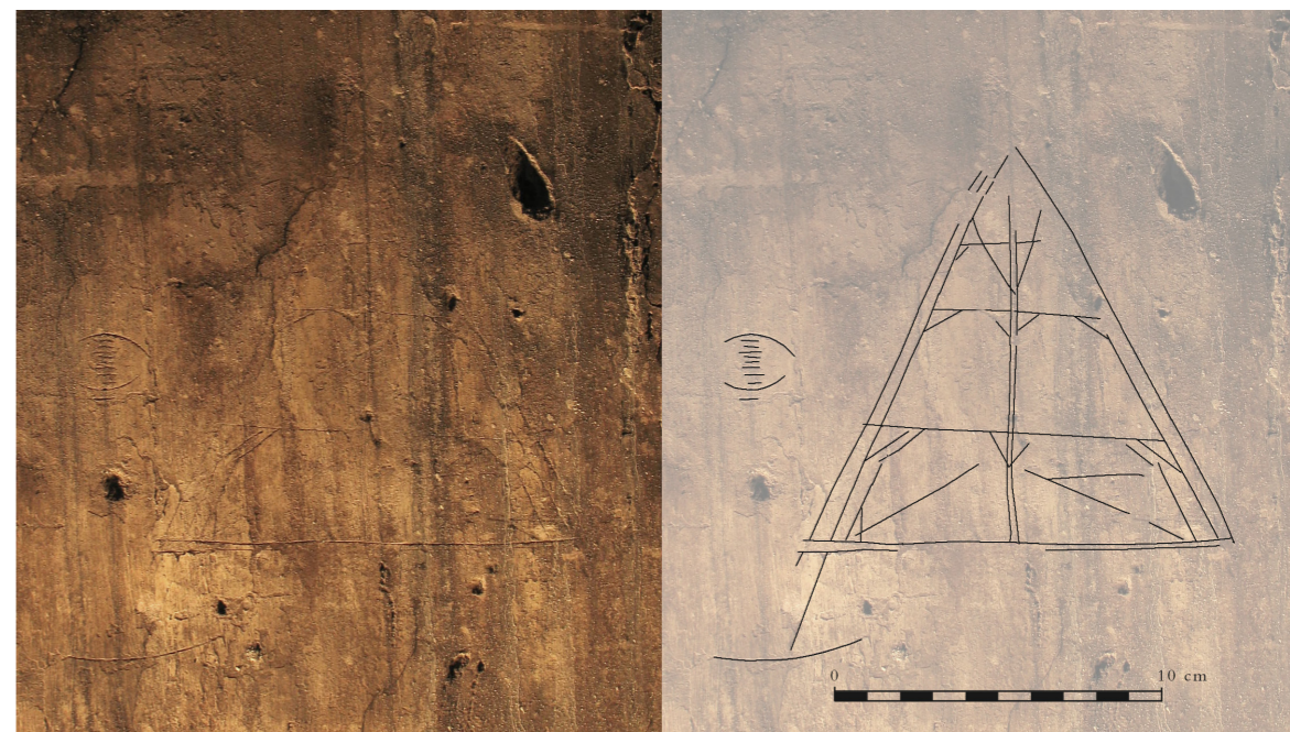
▲ Fig. 64 : graffiti de chantier : schémas de la charpente médiévale et projet de toiture basse. Vraisemblablement fin XVII e siècle ; sur un mur, 2 e étage de comble du musée des beaux-arts.
