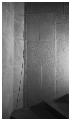
▲ Fig. 190 : porte de visite (murée) du faîtage, ouverte dans la petite vis de la grande tour.
