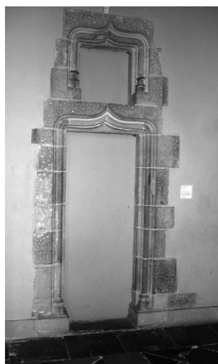
▲ Fig. 138 : porte entre la grande salle et la garde-robe ducale. Le fenestron sert à éclairer le local de chargement du poêle et sans doute les latrines. (Cl. S. Jugie, mars 2011, avant mise en peinture.)
