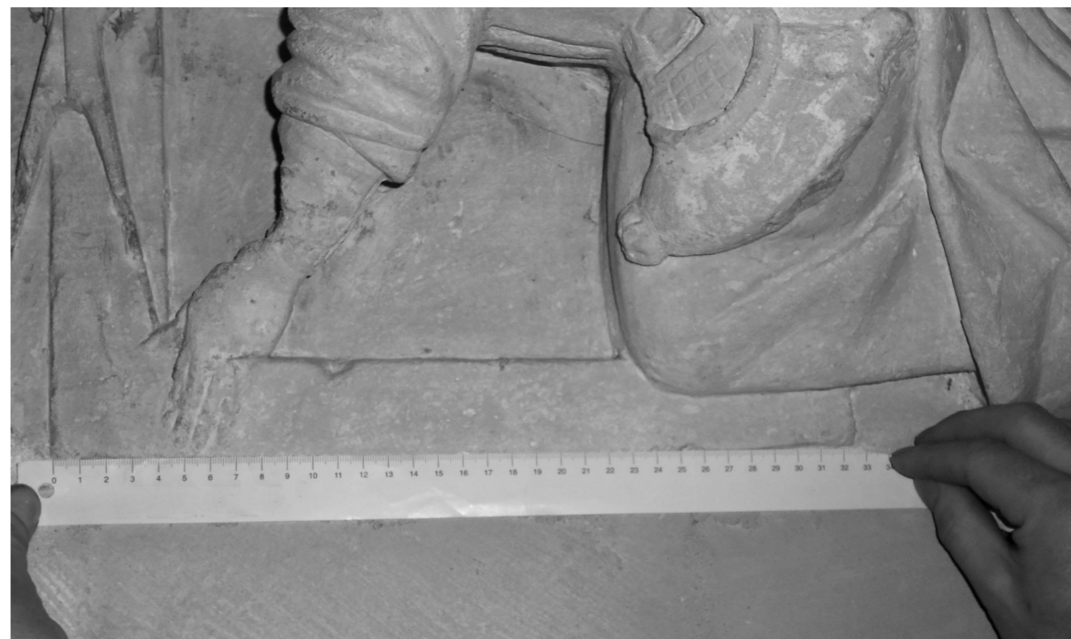
▼ Fig. 67 : paradoxalement, sur la console de l'architecte, l'équerre du maître mesure 32,5 cm, donc un pied royal, plus grand que le pied du chantier.
