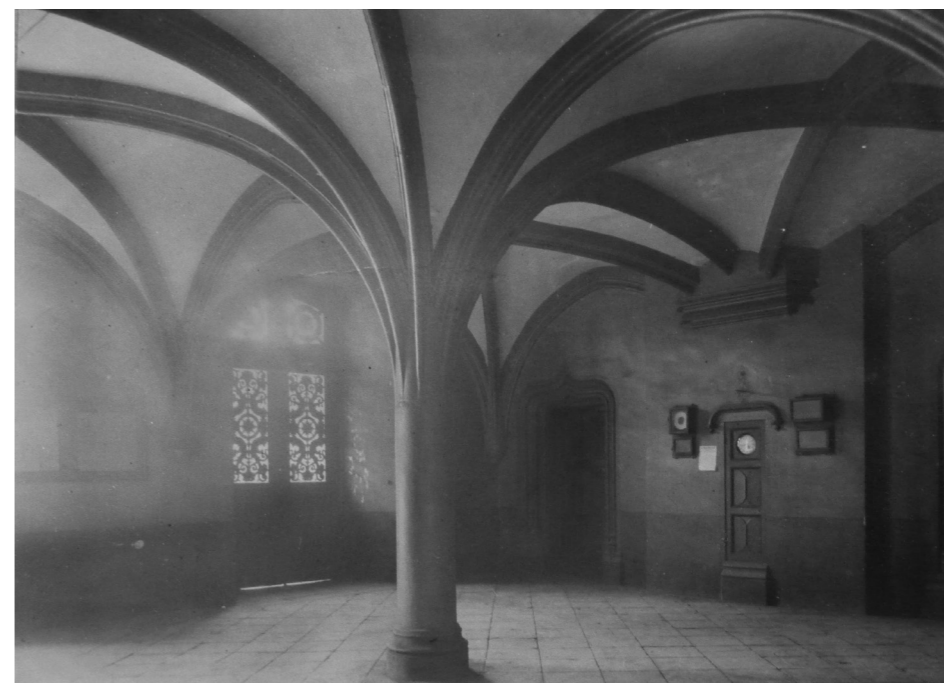
▲ Fig. 126 : chambre occidentale des joyaux vers 1900 (aujourd'hui accueil mairie). La porte qu'on voit à droite du pilier, décorée de moulures pastiches, est percée dans une ancienne fenêtre. À sa droite, la cheminée n'est pas encore reconstruite. (Médiathèque du Patrimoine).
