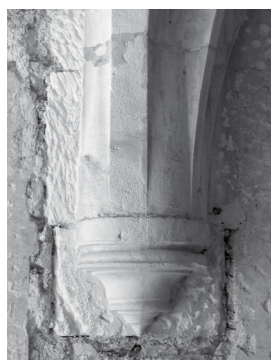
▲ Fig. 122 : culot sud-ouest de la chambre de la vaisselle. La moitié gauche a été taillée dans les queues des pierres après la démolition du mur de refend.
