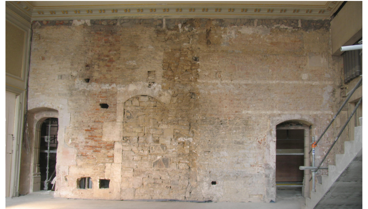
▲ Fig. 136 : mur médian, parement nord de l'actuelle salle des retables. À gauche, garde-robe, au centre, arrachement du mur de refend, à droite, chambre du poêle.
