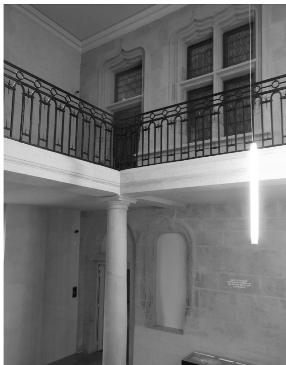
▲ Fig. 82 : travée orientale : baies du rez-de-chaussée et du 1 er étage.
