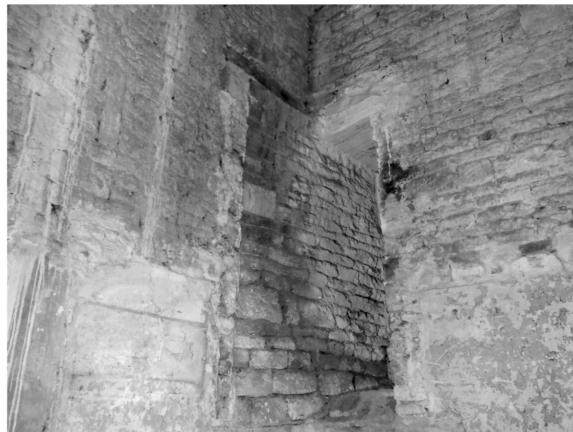
▼ Fig. 202 : passage percé pour Charles le Téméraire en 1474. À gauche, le passage (muré) vers les retraits ; au centre, le passage (ouvert) vers les galeries Rouges à travers le mur du castrum .
