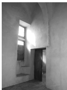
▲ Fig. 191 : demi-croisée de la chambre du 6° étage, surélevée et partiellement bouchée par un mur de refend.
