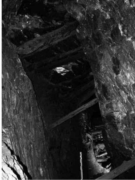
**Fig. 3.** *Cliché de la Grande Fosse pris depuis le point bas sud-ouest avec vue des boisages en place conservés in situ (étais, plancher et barrage) (cl. B. Ancel).*
