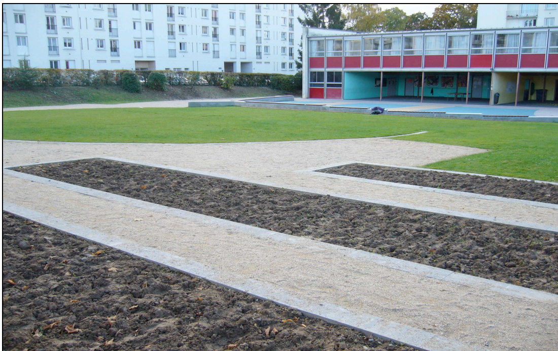
Figure 1 : Photo de la cour de l'école F. Mistral (Tours, 37) après rénovation du substrat et engazonnement, et avant plantations (photo V. Philippot, novembre 2010)
