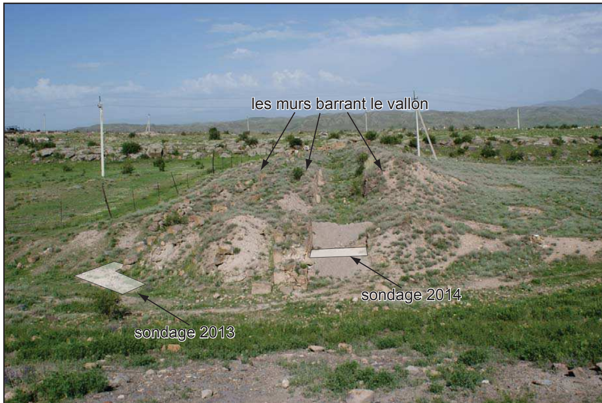
Fig. 110 - Vue générale du dispositif de barrage depuis l'ouest Cliché et DAO : C. Jorda (LA3M, 2014)
