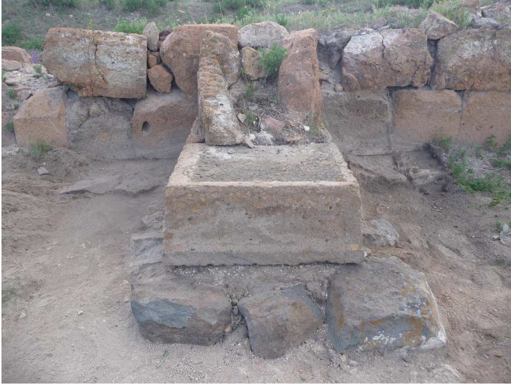
Fig. 57 – Ereruyk. Enceinte orientale. Saillant-contrefort SAL 1610 vu de l'est. Cliché : A. Hartmann-Virnich (LA3M, 2014).
