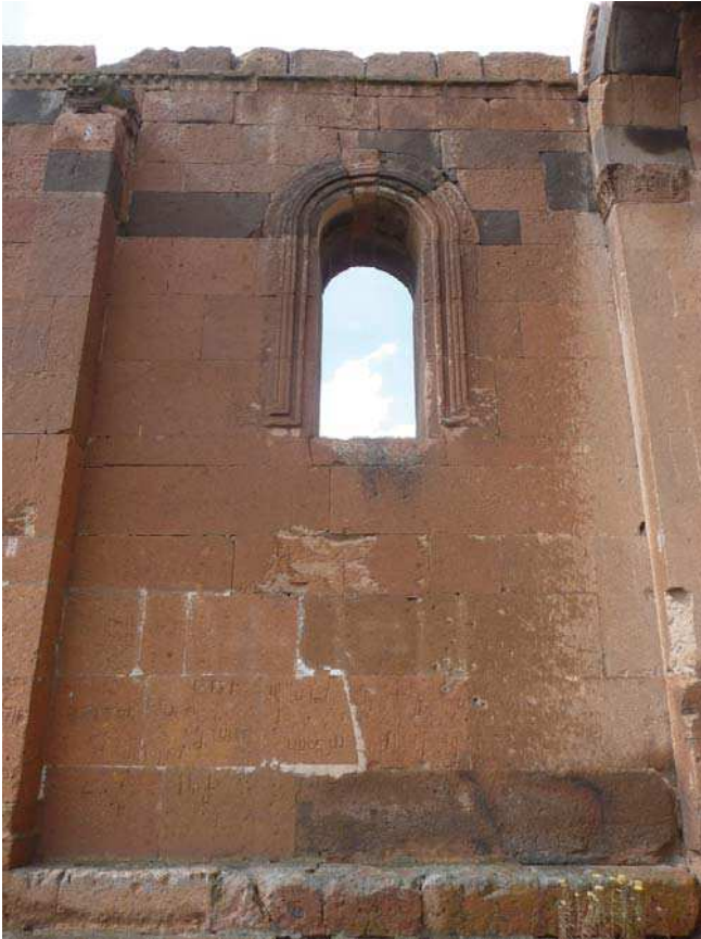
Fig. 27 – Ereruyk. Basilique, façade sud. Dernière travée orientale. Cliché : A. Hartmann-Virnich (LA3M, 2014).
