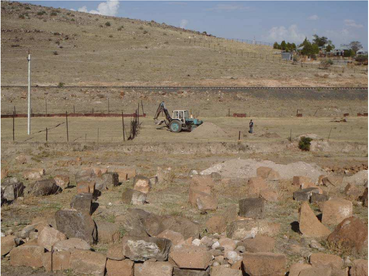
Fig. 106 - Creusement du sondage en 2012, au pied de la basilique. Vue vers l'est. Cliché : C. Jorda (LA3M, 2012)
