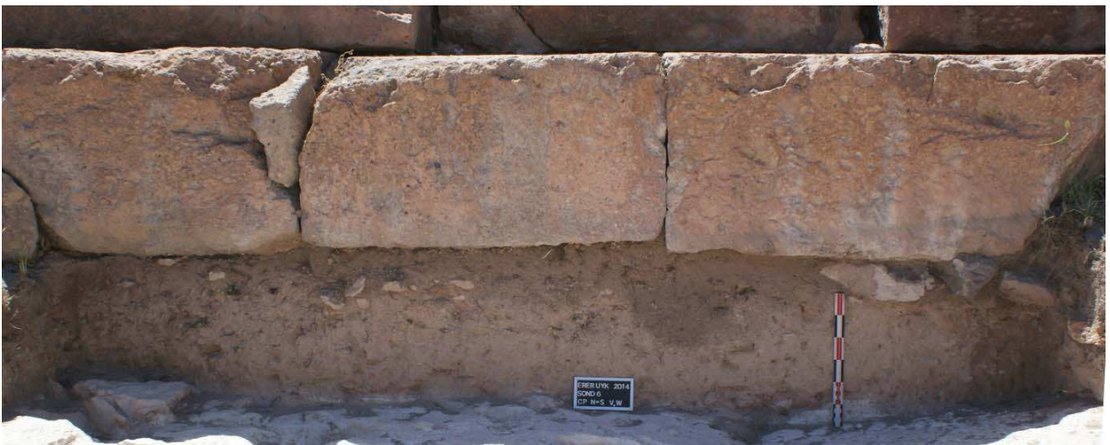
Fig. 87 – Photographie de la coupe vue ouest de la partie occidentale du sondage 6 Cliché : F. Krähenbühl (LA3M, 2014).
