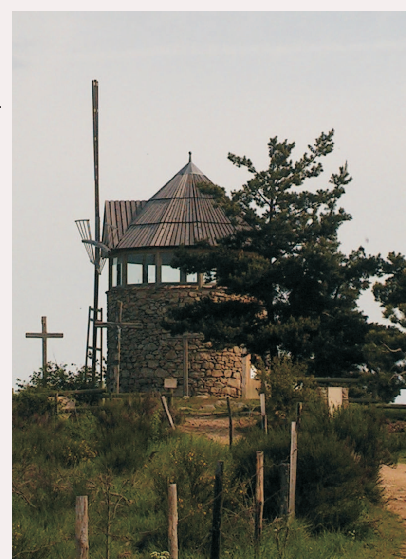
Moulin panoramique (aménagé en 2006)
