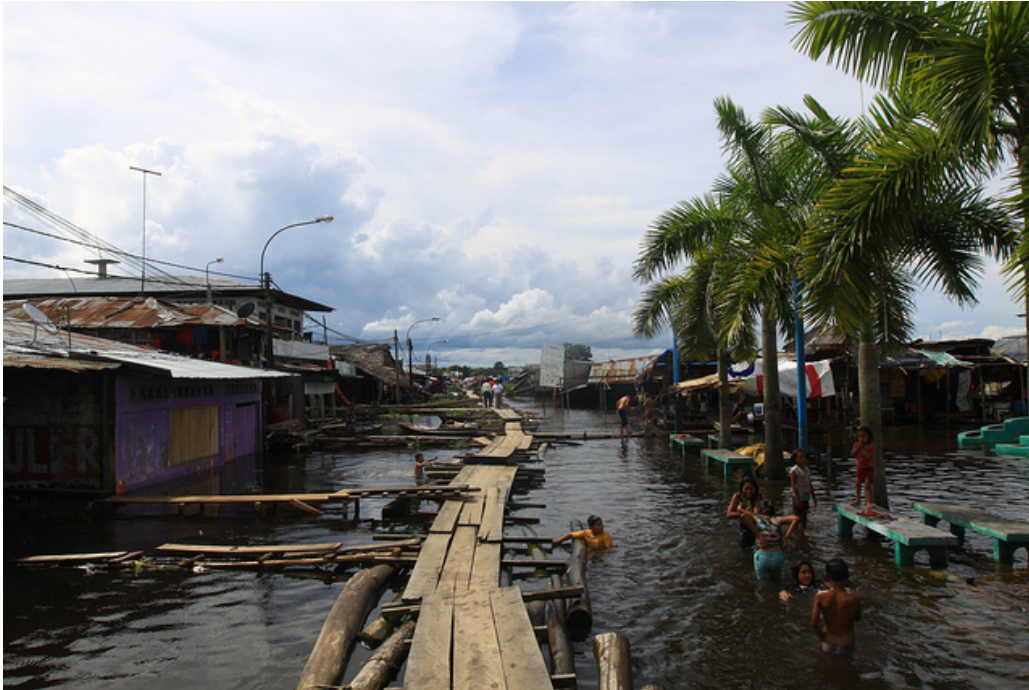
Figure 4 : Inondation dans la ville d'Iquitos en 2012. Photo : William Santini.
