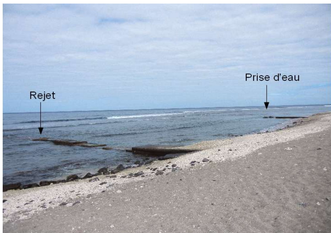
Photo 3. Rejet et prise d'eau du centre de découverte des tortues marines Kelonia (Saint-Leu)
