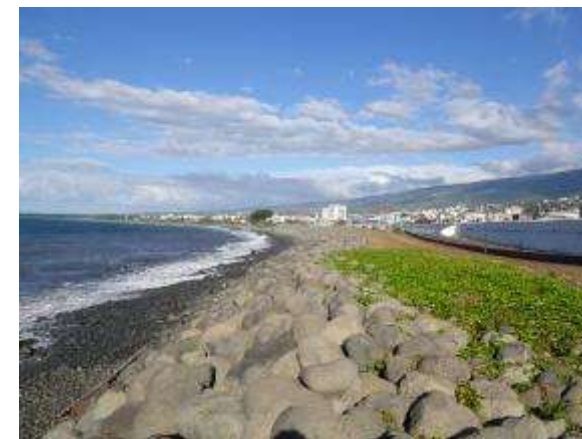
Enrochement sur le littoral de Saint-Denis
