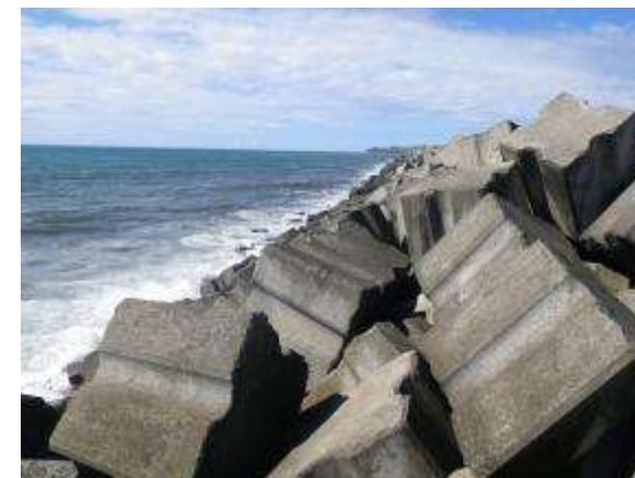
Blocs cubiques rainurés protégeant l'aéroport Rolland Garros
