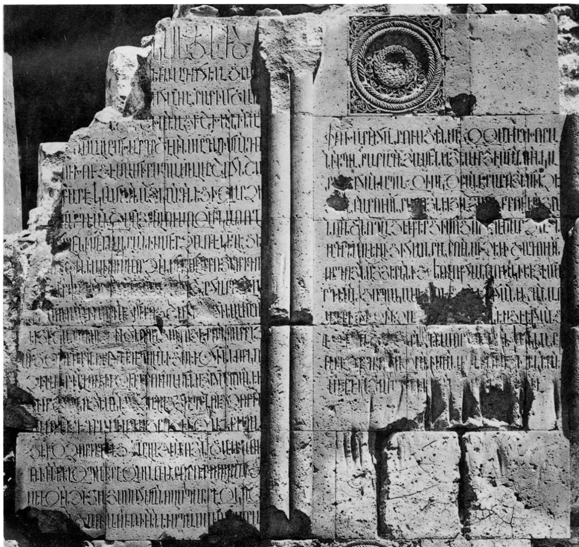
Fig. 19 (p. 278) – Ani. Eglise Sainte-Mère de Dieu du Fort de la Fille. Façade sud.
