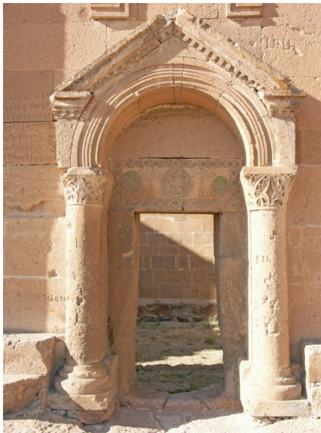
Fig. 10 (p. 254) – Ereruyk'. Basilique. Façade sud, portail est. Photo P. Donabédian (LA3M, 2013).
