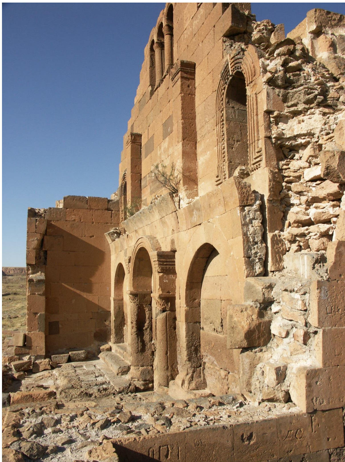
Fig. 17 (p. 272) – Ezeruyk'. Basilique. Façade ouest, maçonnerie adossée pour l'adjonction d'un nouveau portique. Photo P. Donabédian (LA3M, 2013).
