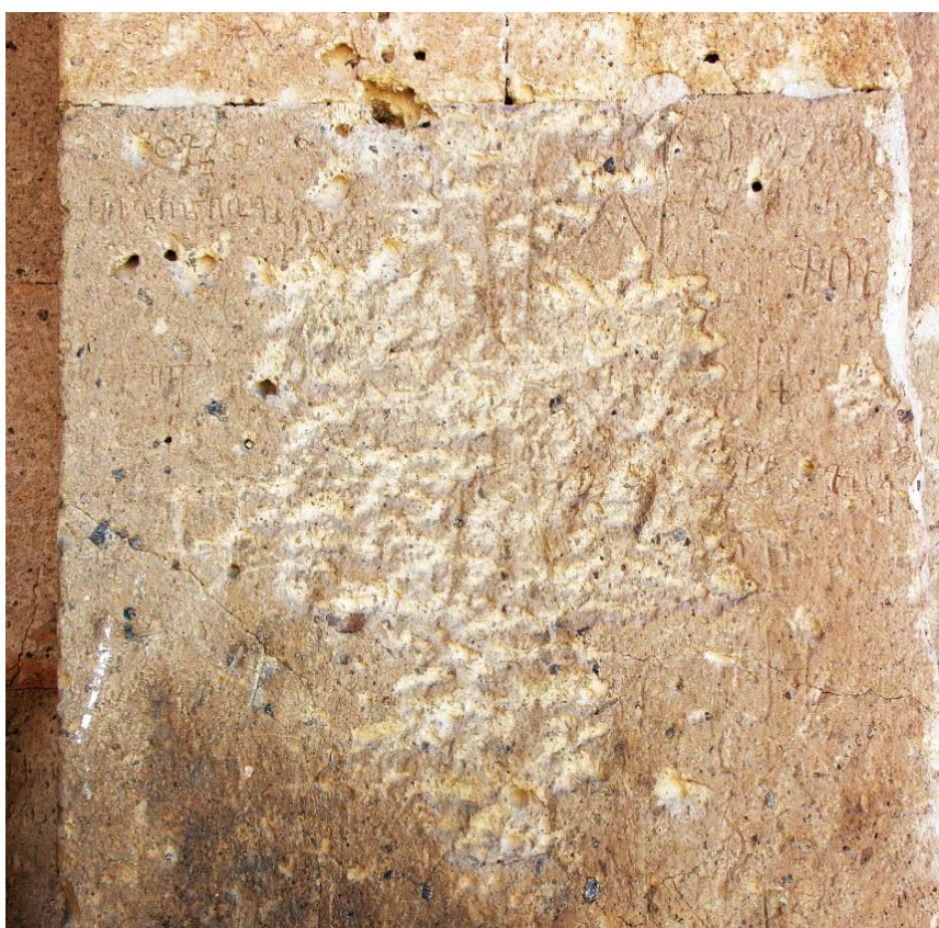
Fig. 15 (p. 268) – Ereruyk'. Basilique. Chambre sud-est, face ouest. Restes d'une inscription grecque près d'une croix martelée. Photo P. Donabédian (LA3M, 2013).
