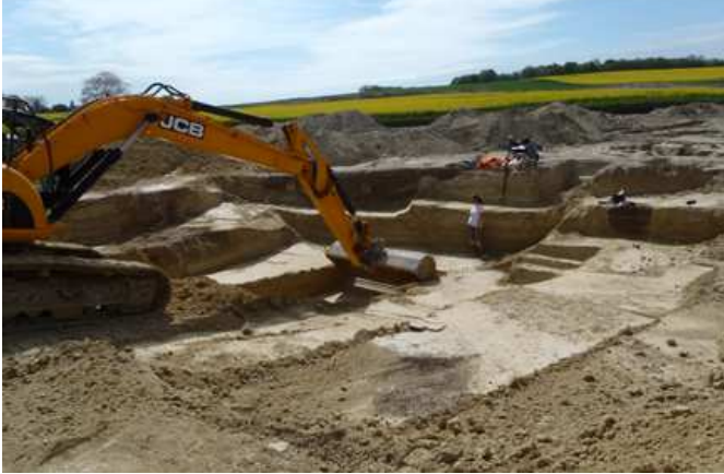
Fig. 3 décapage en cours d'un caisson profond, avec ses paliers de sécurité, du souterrain n°2 (Crédit Inrap 2013)
