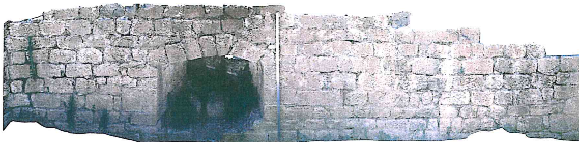
Vue du parement intérieur du rempart dans la cour 1
