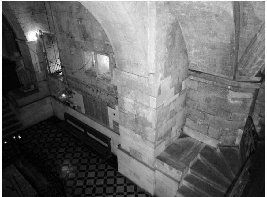
Fig. 20 - Saint-Gilles-du-Gard, crypte, travée de la confession, pilier nord-est (avec traces de chaînage et de restauration).
