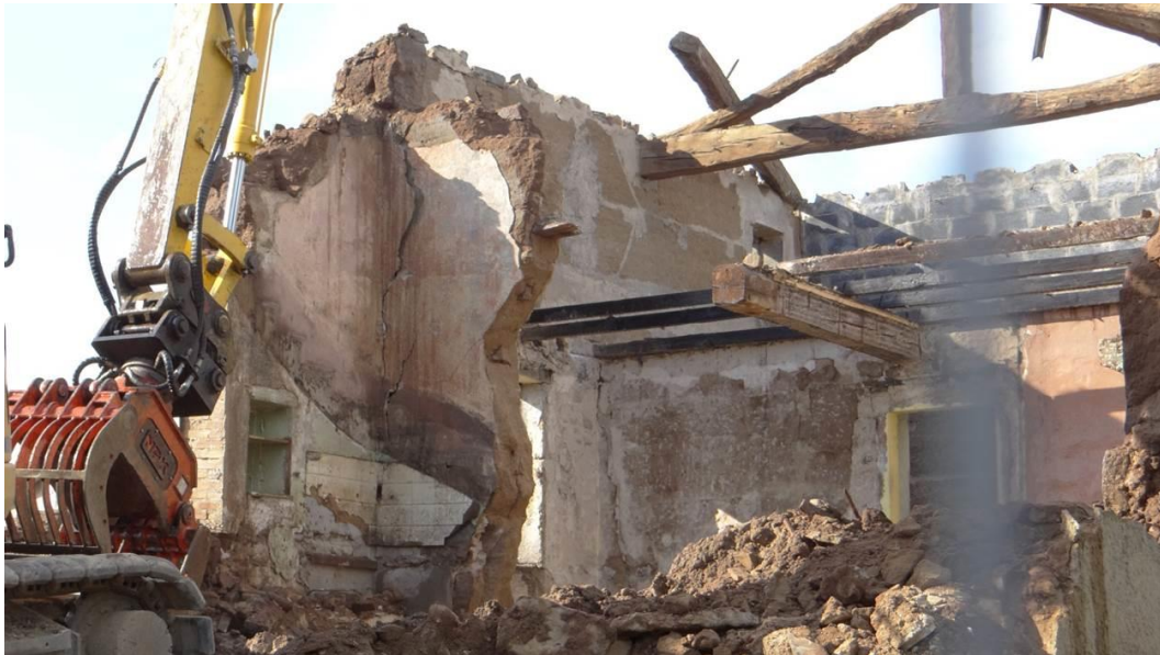
Fig. 2 : Matériaux et structure d'une maison révélés lors de sa démolition Ancien siège du syndicat des blanchisseurs à Saint Genis les Ollières (69)
