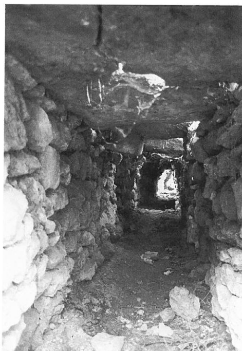
Figure 11. Égout collecteur vu de l'intérieur (mai 1986).
