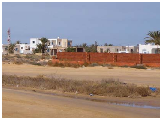
Photo 3 : Chantier de construction d'une habitation dans une sebkha in Kellabine. Construction site into a sebkha in Kellabine
