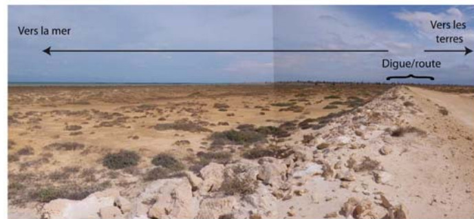
Photo 4 : Digue/route récente bloquant les échanges d'eau entre terre et mer donc le fonctionnement de la sebkha Sea-wall/road blocking the water exchange between land and sea and the sebkha
