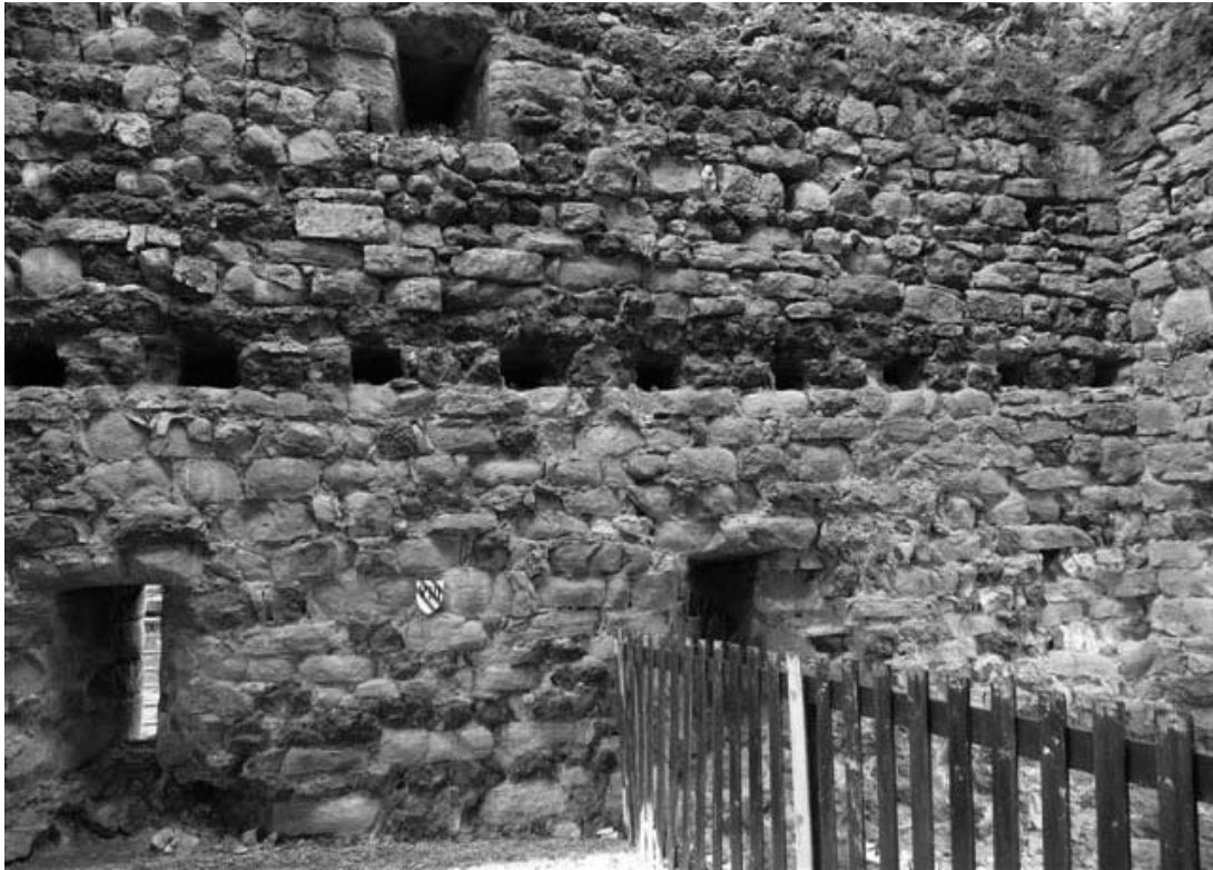
Fig. 5 : face intérieure nord ; rayères et empochements des solives (photo R.-P. Lehner).
