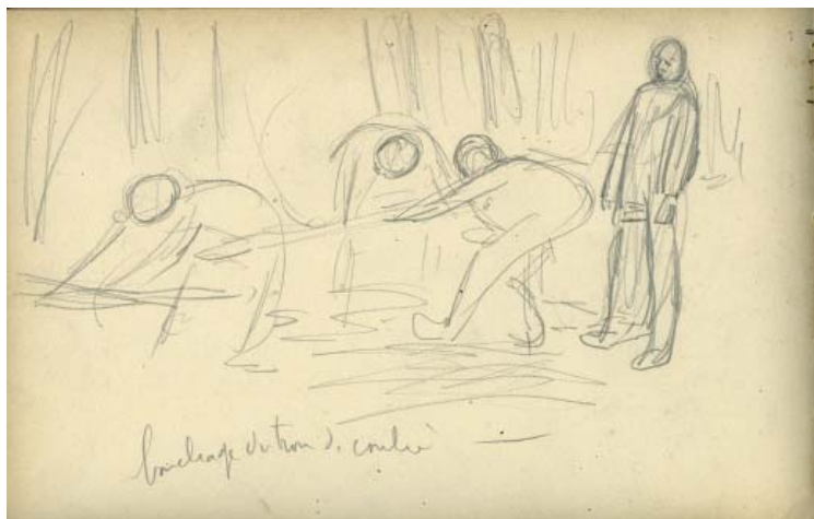
Dessin 39 : [Réparation du trou de coulée ]
