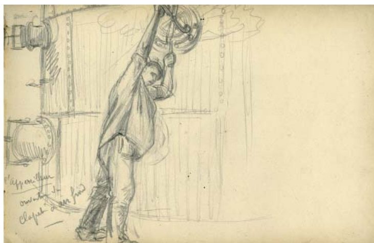
Dessin 40 : [L'appareilleur : ouverture du clapet d'air froid]
