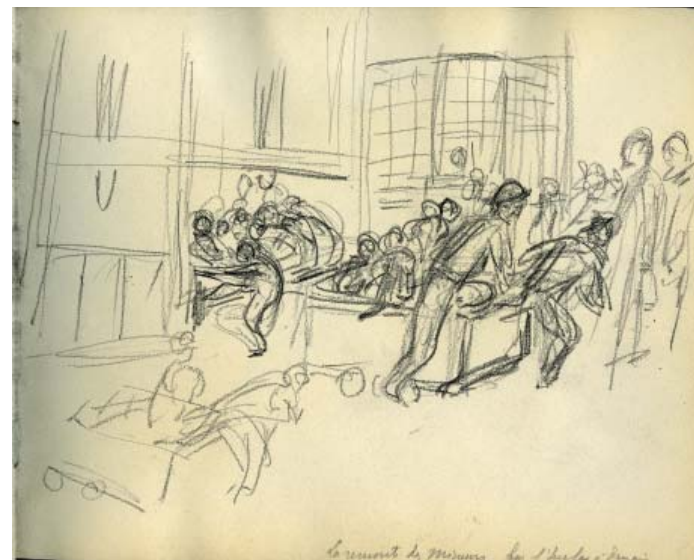
Dessin 17 : La remonte des mineurs - Fosse l'Enclos à Denain Mine de plomb et fusain l. 26,5 x H. 21,2 cm Inscription de la main de l'artiste : « La remonte des mineurs - Fosse l'Enclos à Denain ».
