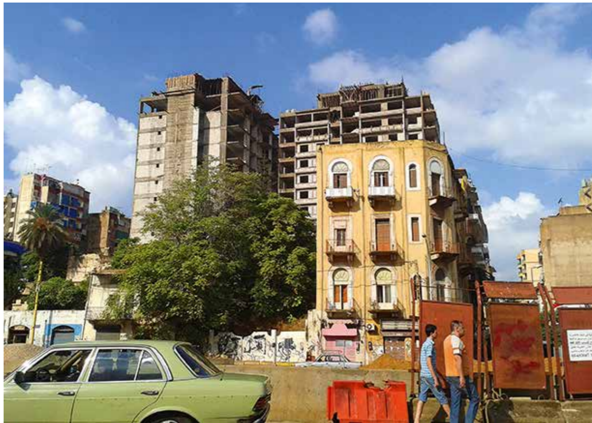
Fig. 2. Beyrouth : reconstruction, gentrification et destruction composent un paysage urbain de plus en plus anarchique.
