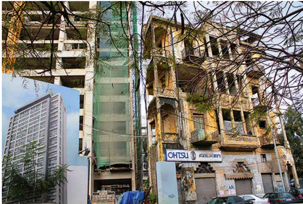
Fig. 4. Beyrouth : les stigmates de la guerre civile (1975-1991) côtoient encore la spéculation immobilière en plein quartier résidentiel. Ici, rue de Damas, sur l'ancienne ligne de démarcation entre l'est et l'ouest.
