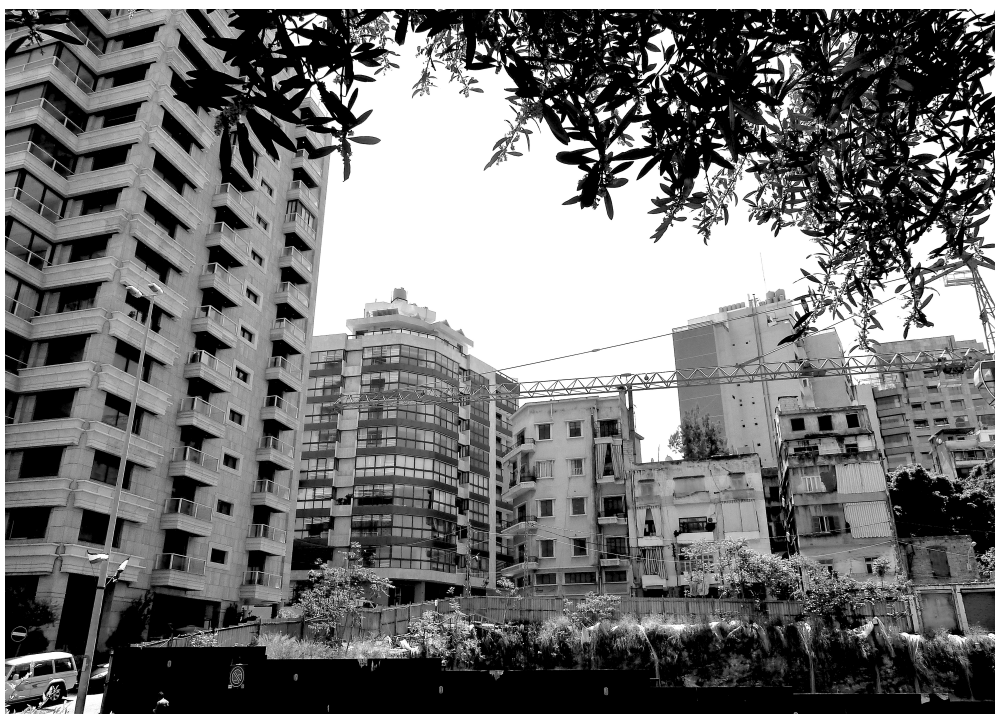
Photo 1 : Les quartiers péricentraux de Beyrouth juxtaposent des tours neuves d'appartements de luxe et des immeubles anciens dégradés, souvent habités par des détenteurs de baux locatifs anciens ©Valérie Clerc 2012.
