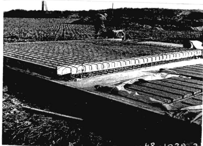
③ Coulage du ciment
