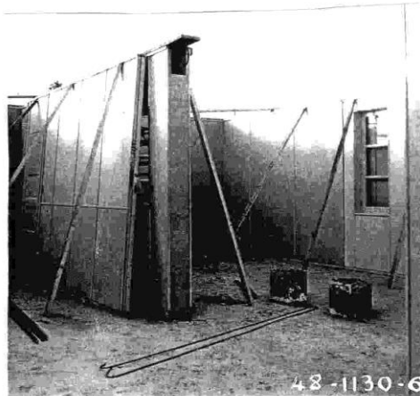
⑥ Pose des cloisons
