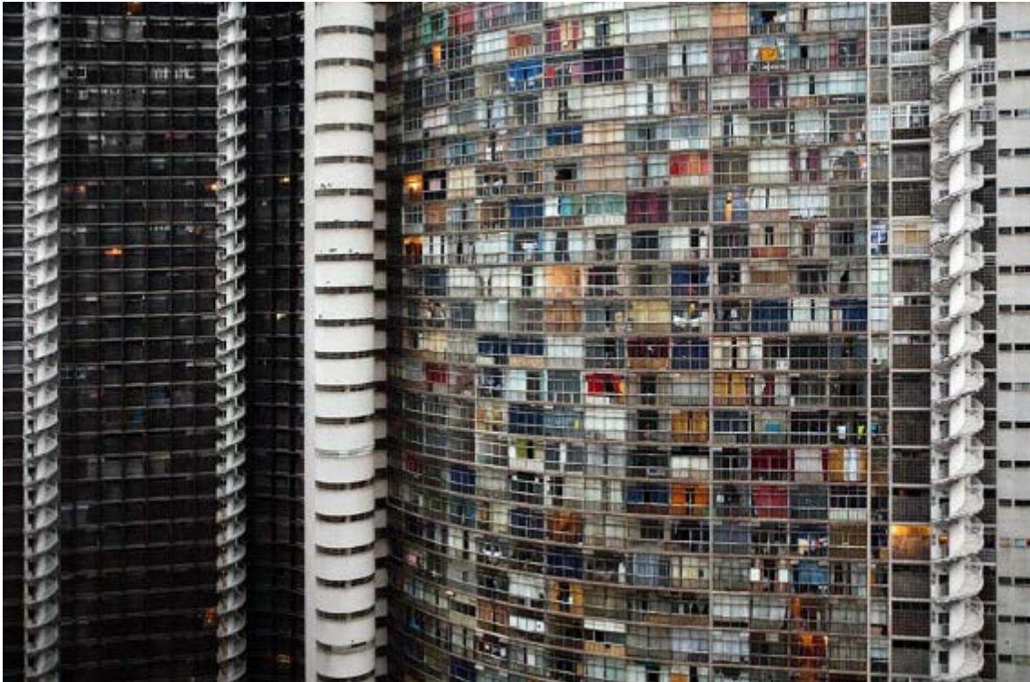
Photo 7 Immeuble du centre de São Paulo
